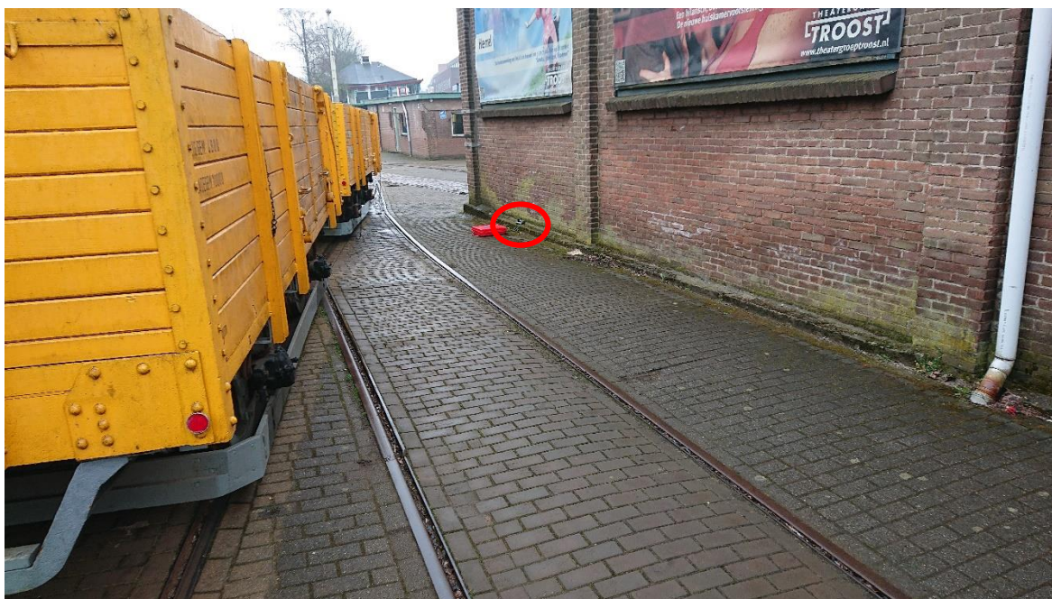
Figuur I.7 Meetpunt 3 op fundatie loods
