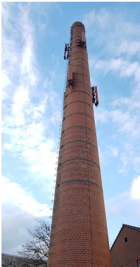
De hoge schoorsteen met uitkragende bovenrand
