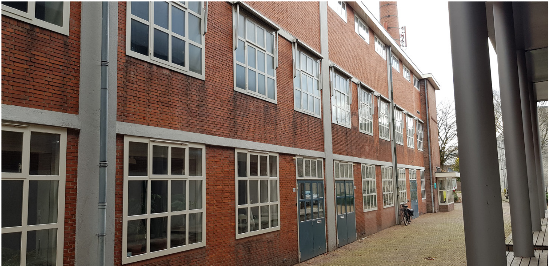
Metselwerkgevels zijn ingevuld met deels nog stalen kozijnen en ramen. De tweede etage met kleinere ramen is later toegevoegd
