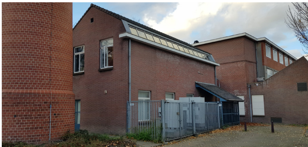
Het in traditionele stijl en materialen opgetrokken ketelhuis
