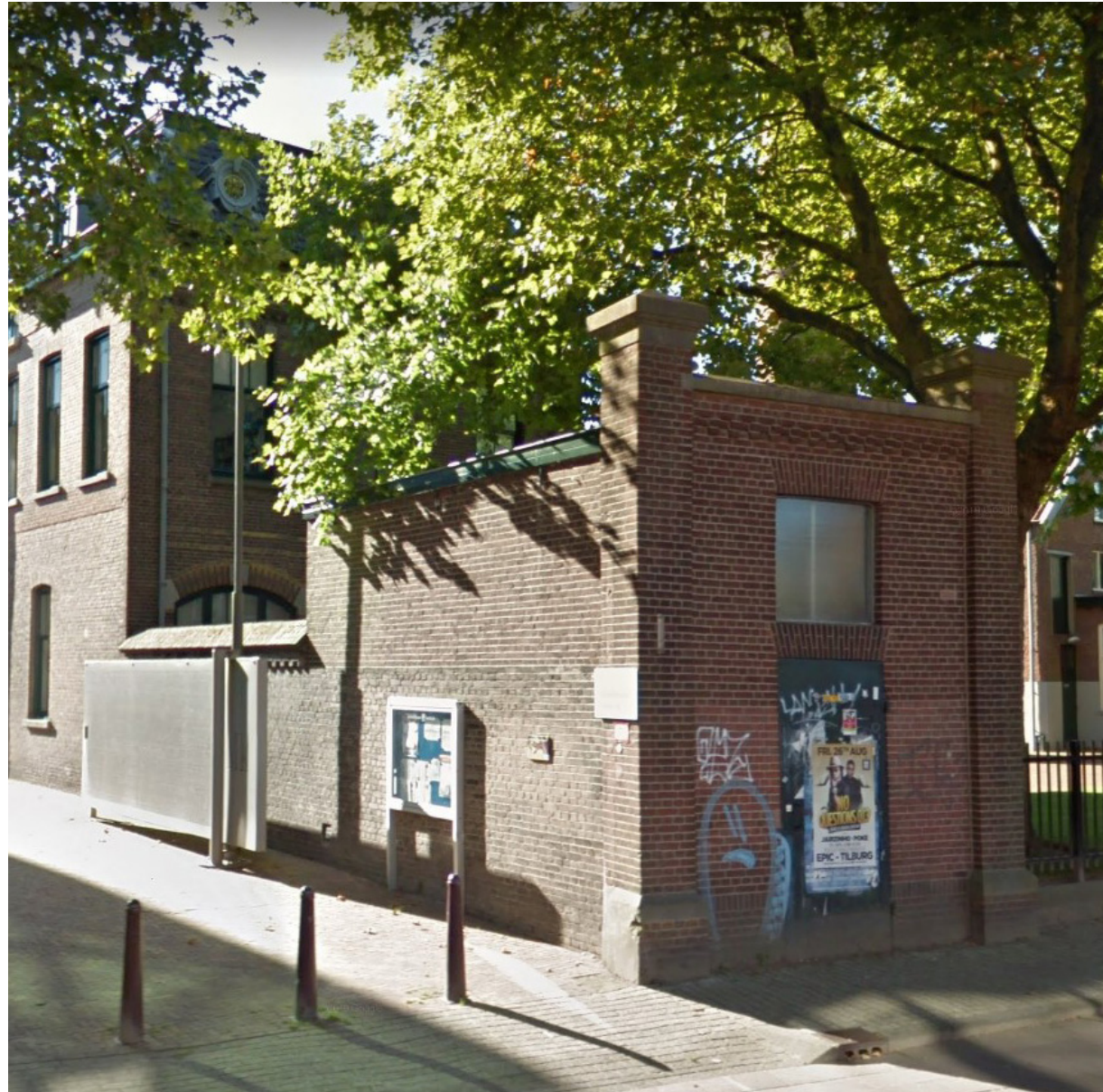
Het transformatorhuisje staat in de lijn van het woonhuis. Eraan vast bevindt zich de oude muur.
