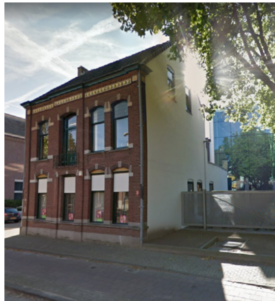
Voorgevel aan de Goirkestraat, in dezelfde rooilijn als de overige gevels van de straat
