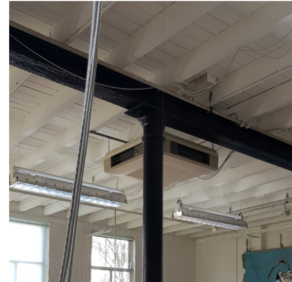
Originele dakconstructie in de voormalige lijmerij
