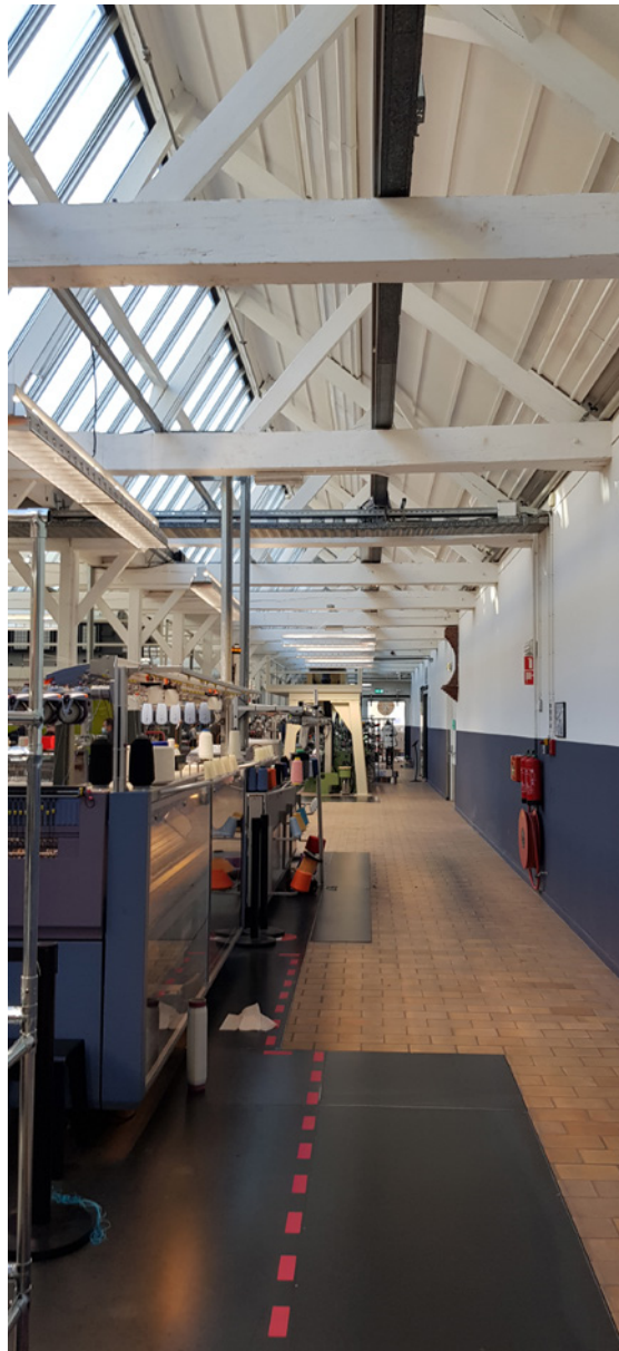
Originele dakconstructie in de voormalige weverij
