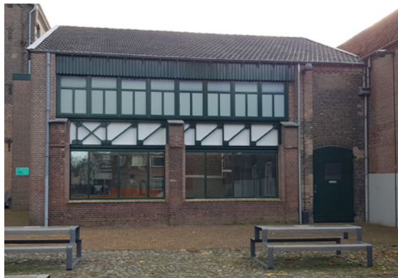
Ketelhuis met karakteristiek stalen vakwerk in de gevel
