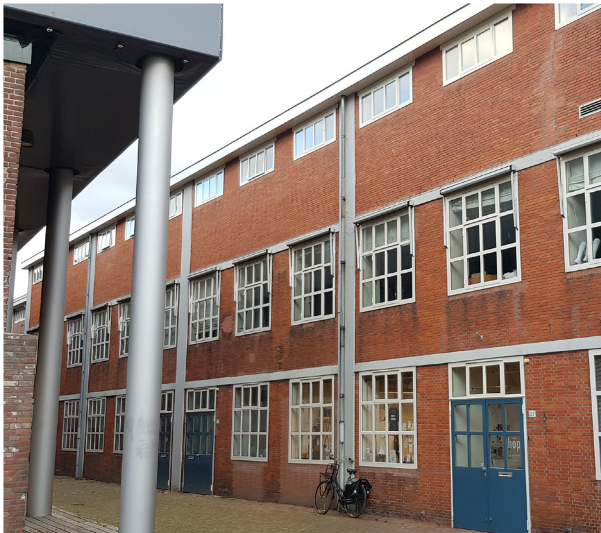
De betonnen constructie en metselwerkgevels worden bouwhistorisch hoog gewaardeerd.
