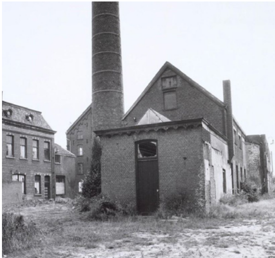
De handwerfabriek met latere schoorsteen
