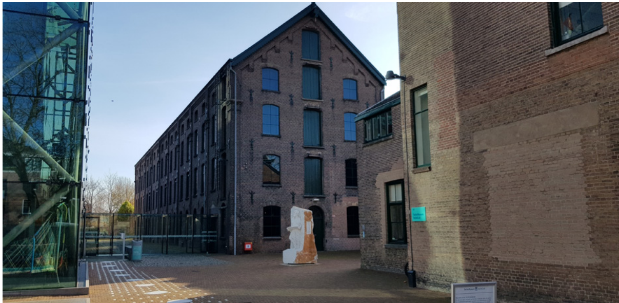
De in 1984 gerestaureerde gevel
