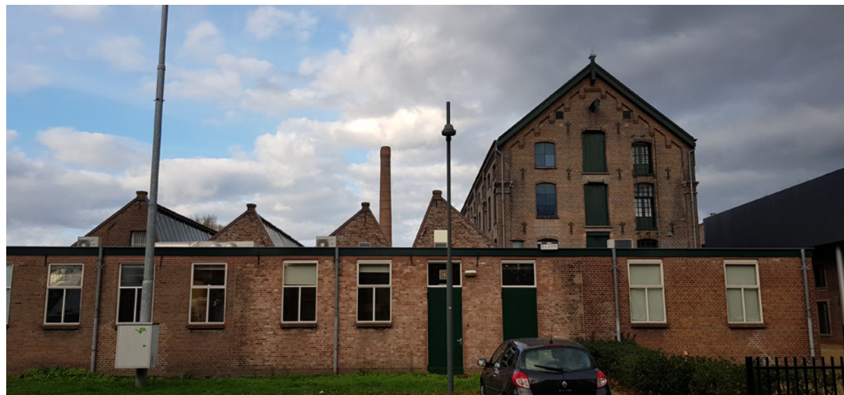
In de gevel is zichtbaar dat het gebouw in fasen is gerealiseerd
