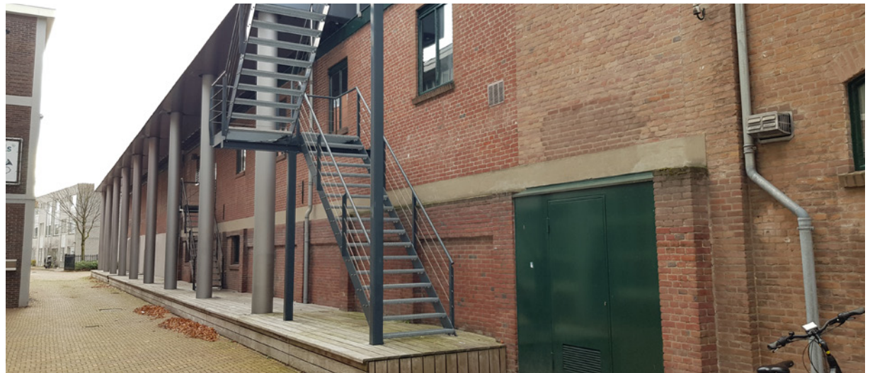
De bergplaats met enkele raamopeningen. De grijze kolommen dragen het in 2008 toegevoegde depot
