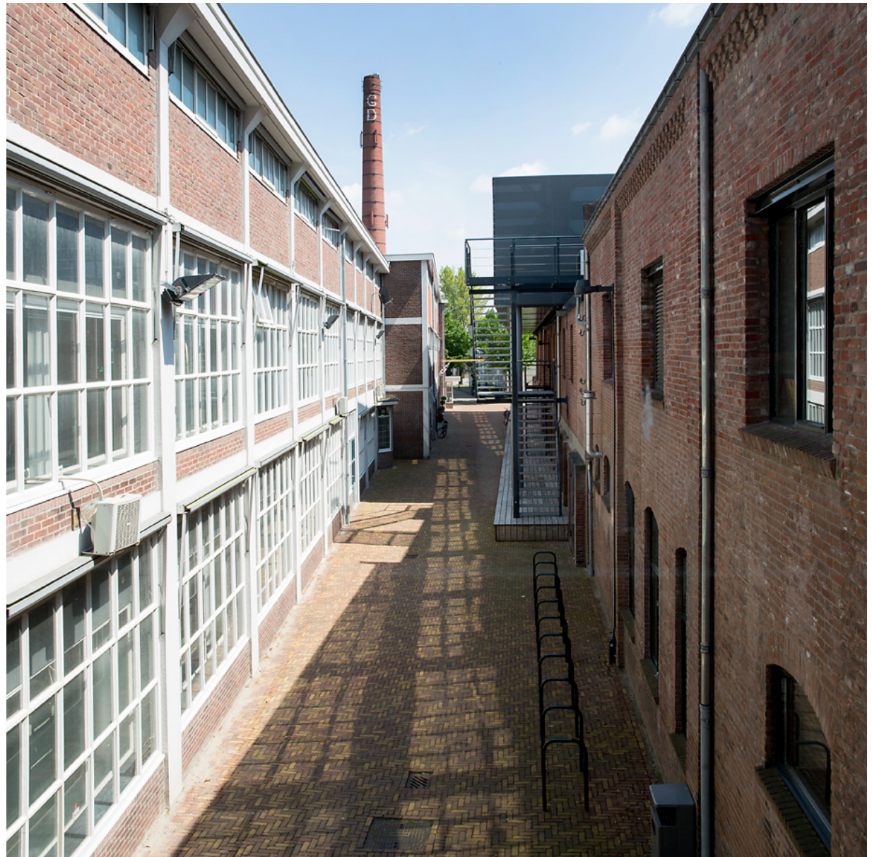
In de binnenstraat is duidelijk het verschil te zien tussen gesloten 19e-eeuwse en de lichtere 20e-eeuwse bouw
