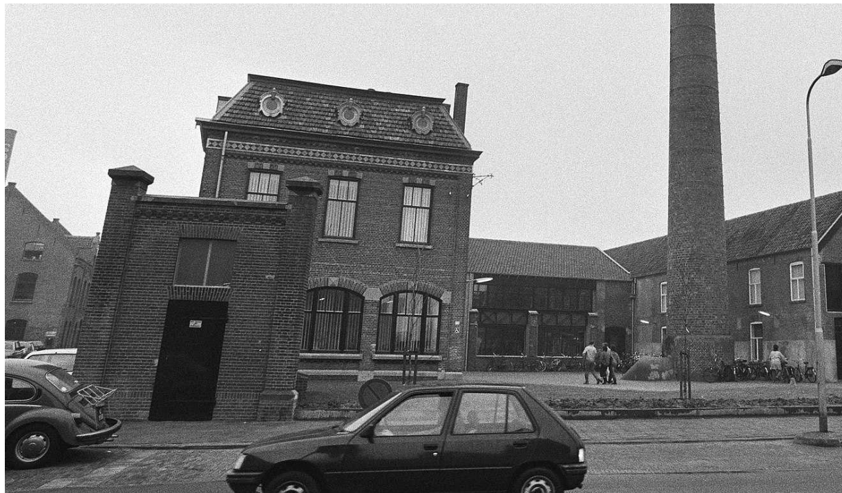
Transformatorhuisje aan de Goirkestraat, met op de achtergrond de kantoorvilla // bron: Regionaal Archief Tilburg
