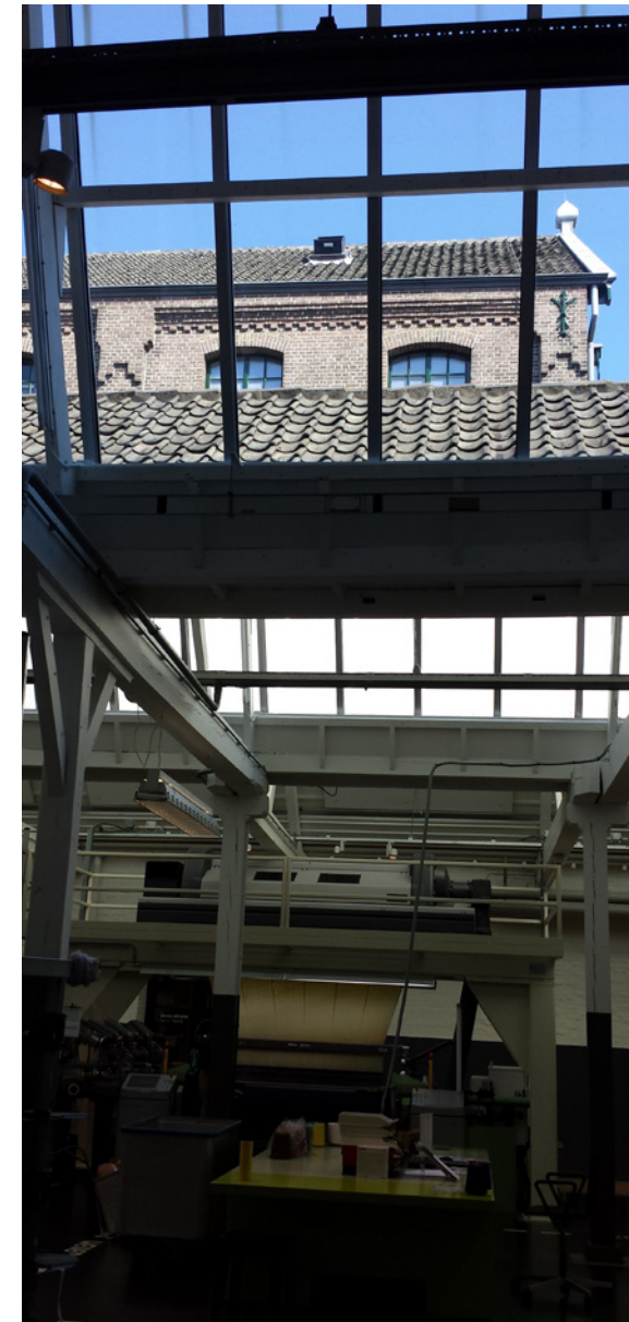
Zicht op de spinnerij door de sheds van de weverij
