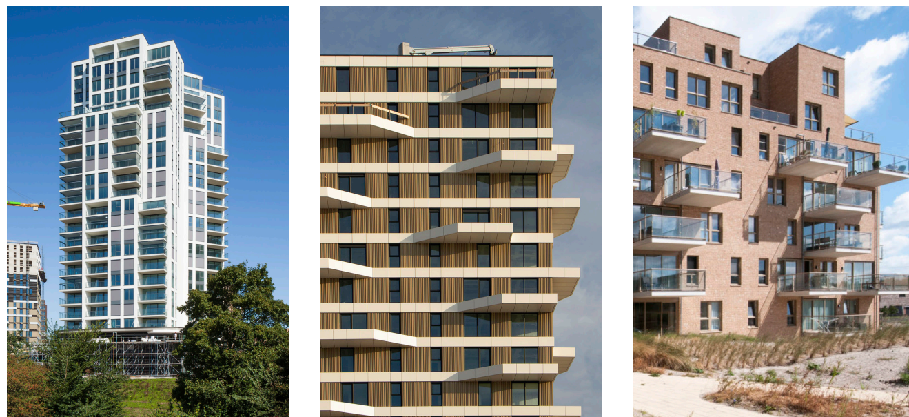
gerealiseerde woongebouwen Kop Zuid (Klunder architecten in opdracht van Amvest) links woongebouw San Francisco 73m, benadrukt qua vorm en volume opbouw de hoogte, midden Valencia 50m met een sterke horizontale geleding en rechts woongebouw het Anker 30m met een afgetrapte bovenzijde (afbrokkeling)
