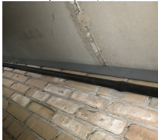
Foto 2: aansluiting scheidingswand op (dak)vloer
