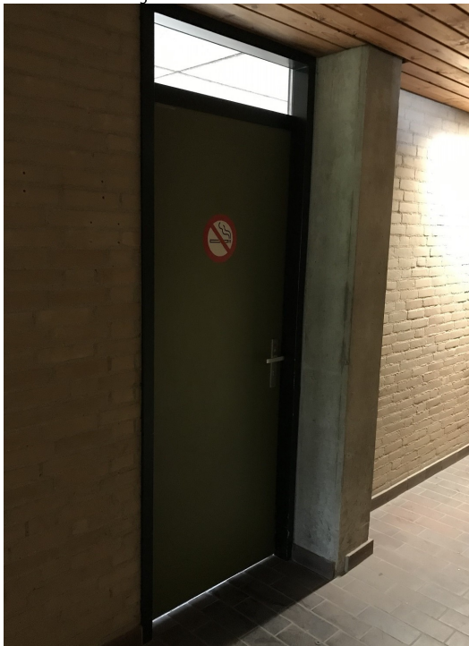
Foto 5: scheidingswand kantoor - verkeerszone
