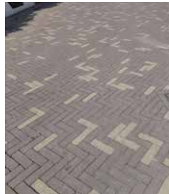
Afb. 1.1 Voorbeeld van een afwijkende kleur klinker in straatwerk.
