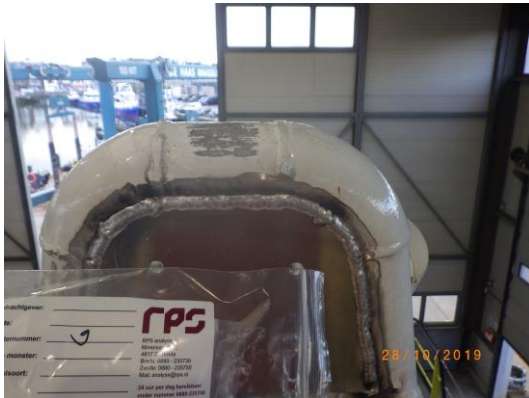
foto 18: Overzicht M09 Mast (wit)
