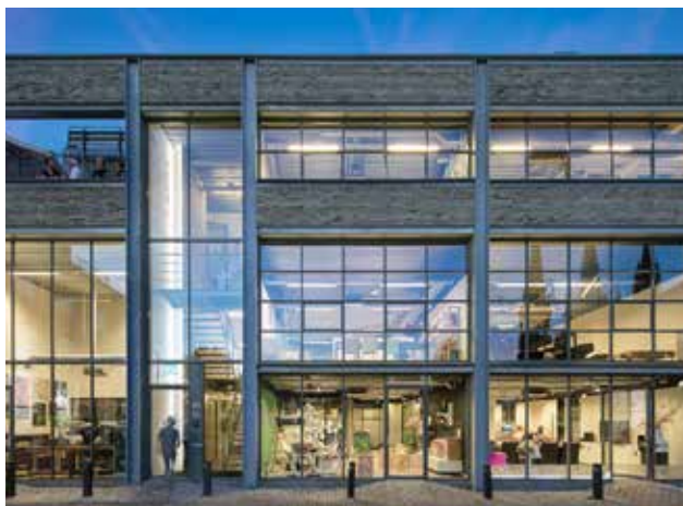
Werksoekel (Ed Bergers Architecten, Tilburg)
