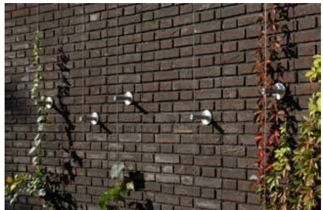
Voorbeeld van de bevestiging van staaldraad aan een gevel t.b.v. windende klimplanten
