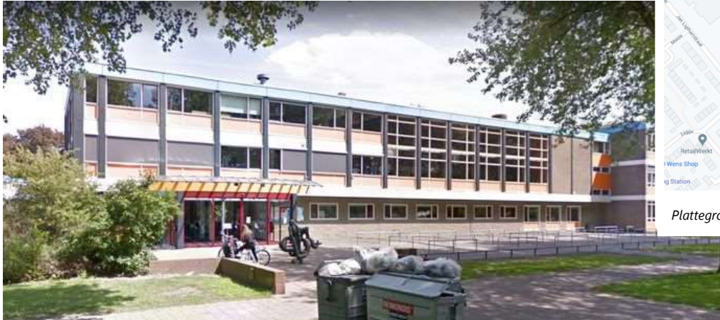
Foto van frontgevel Jan Ligthartstraat 1
