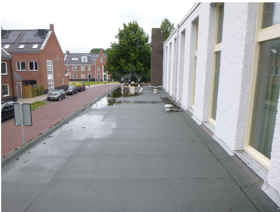
Foto 1: Zicht op het dak boven de begane grond (zie beperking in § 4.3).
