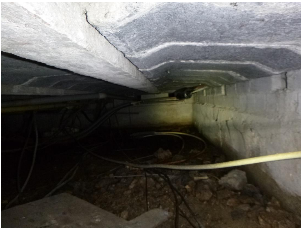
Foto 3: Zicht in de kruipruimte onder het pand (zie beperking in § 4.3).
