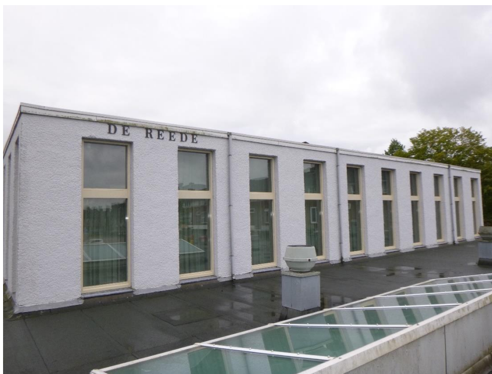
Foto 2: Zicht op het dak boven de begane grond (zie beperking in § 4.3).
