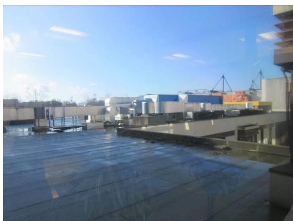
Dak aanzicht hoofdgebouw
