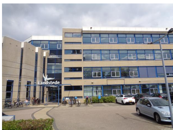
Voorzijde gebouw 2, G-vleugel
