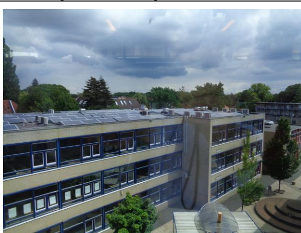
Voorzijde gebouw 2, E-vleugel
