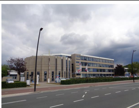
Rechtsvoor gebouw 2 (Westeinde 33, G-vleugel)
