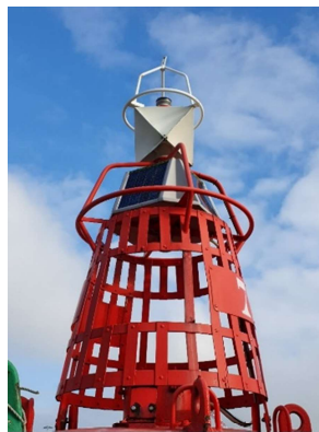
Foto 1: boei met oude elektrische installatie
