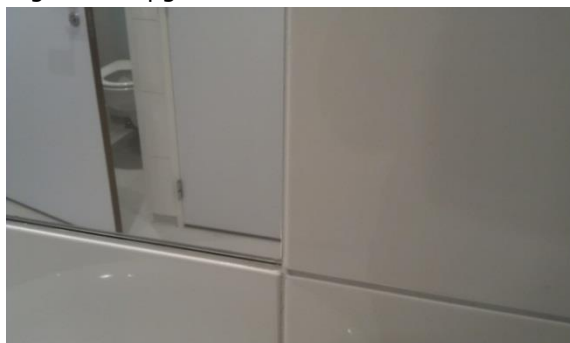
Figuur 3: Spiegels opgenomen in tegelwerk
