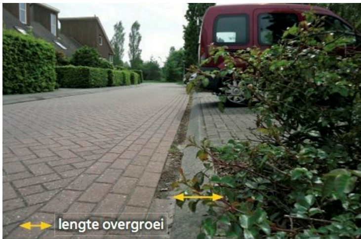
Figuur 4: Meet de overgroei vanaf de buitenste rand van de verharding (inclusief opsluitband)
