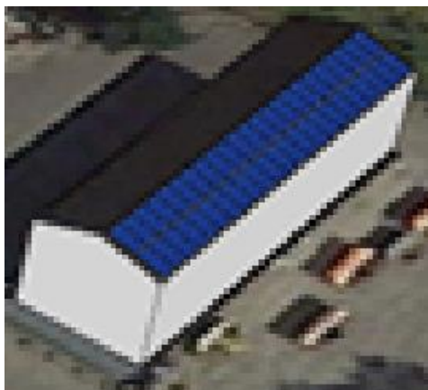
Figuur 3.10 Weergave van zonnepanelen op het dak.
