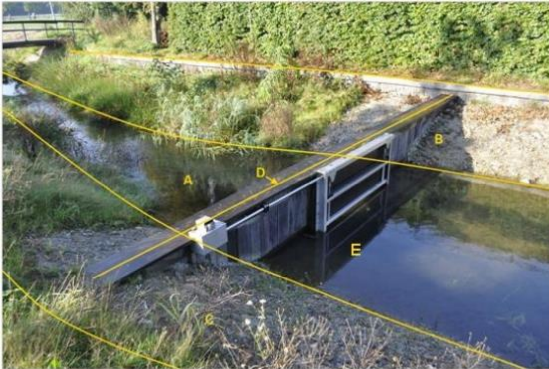
Figuur 2 voorbeeld opsplitsing van waterdelen door stuw <30cm
