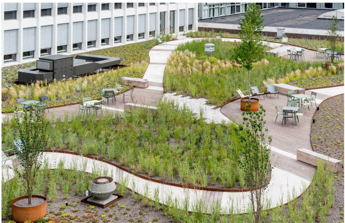
Figuur 31. Voorbeeld van een natuurinclu- sief en klimaat- bestendig dak (bron: Alphons Nieuwenhuis).
