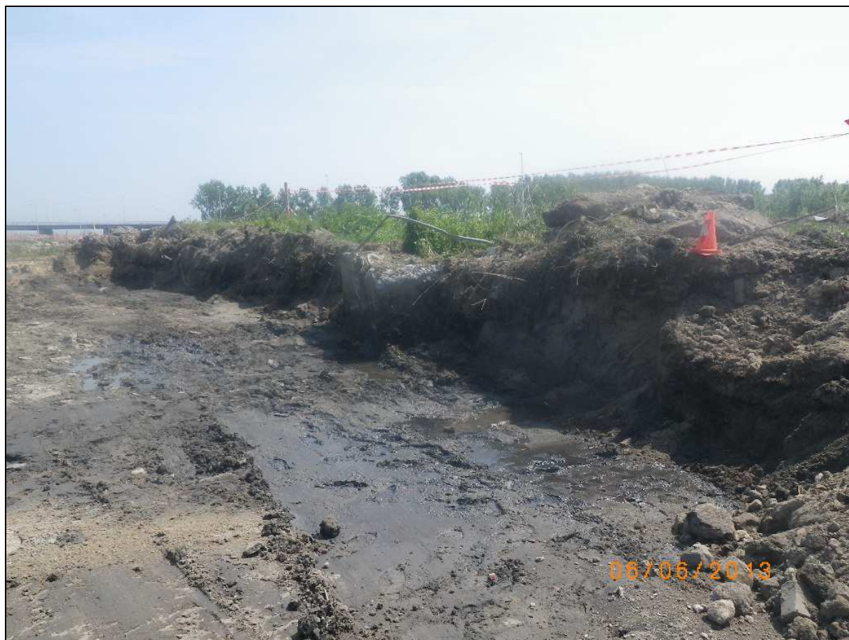
Foto 30. De ontgravingsput van de sanering van de olievlek op spot 20 (6 juni 2013). Gezien vanuit westelijke richting, over ontgravingsvakken B9 en B4. De betonnen constructie in de zuidelijk wand betreft mogelijk de olievangput.
