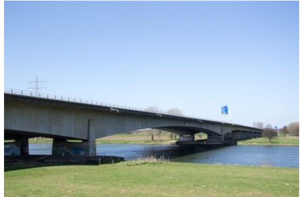
Uitbouwbrug uit 1979 A73, grootste overspanning: 158 m
