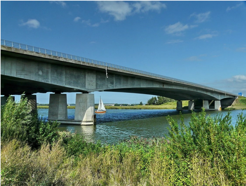
Uitbouwbrug uit 1980/1995 A27, grootste overspanning: 160 m
