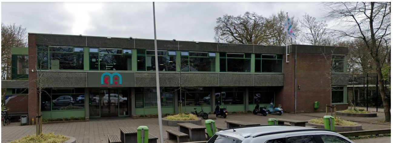
Foto van het Montessori College Aerdenhout in de huidige staat.
