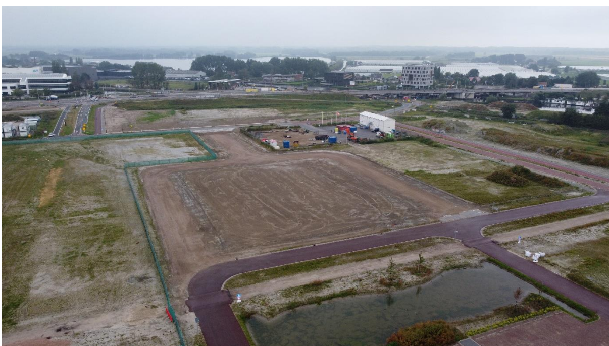
Afbeelding 1: Aanzicht huidige situatie NRZ (in zuidwestelijke richting)
