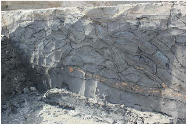
Figuur 4-3 Stapeling van pluggen in één van de dammen.
