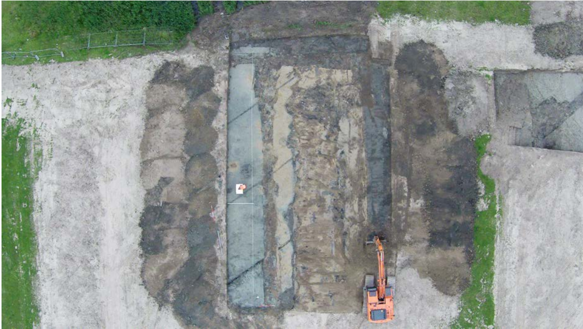
Figuur 3-2 Verstoringen in het vlak van werkput 192 in 2014. Duidelijk zichtbaar zijn de verstoorte banen van kabels en leidingen en de locatie van een barak, zichtbaar als een rechthoekige, verstoorte zone in de rechterhelft van de put. De linkerzone van de werkput is verblauwd door de ophoging ten behoeve van de studentenhuisvesting. De rest van de put is niet verblauwd door de aanwezigheid van een barak. Helemaal rechts in de put is de dichtgestorte werkput 33 te zien, met eveneens sporen van verblauwing. Foto: F. Nederlof.
