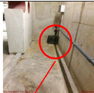
Rooster optillen en bladeren weghalen
