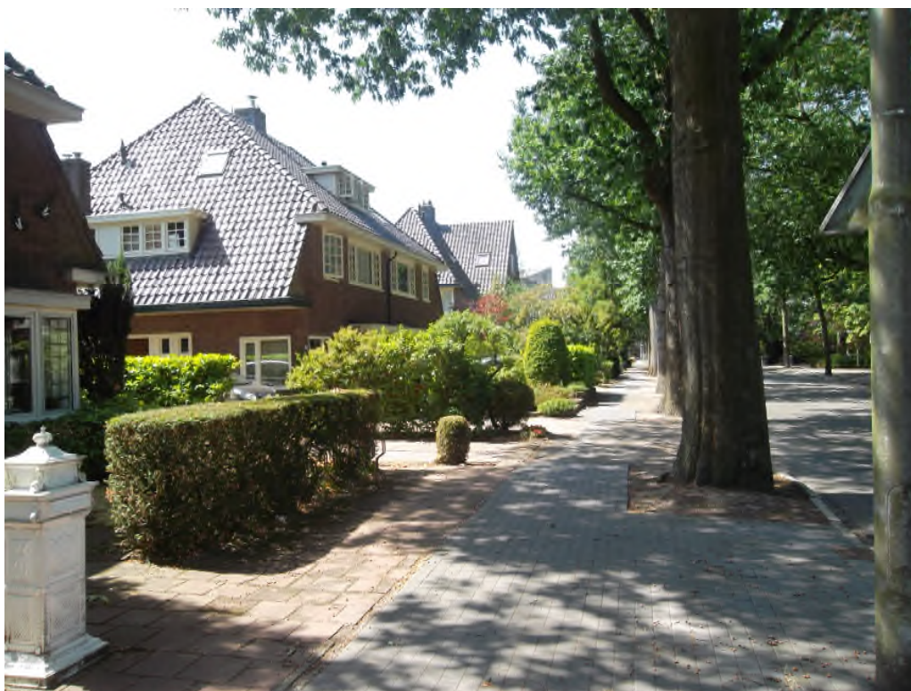
Foto 6. Jan van der Heijdenstraat ter hoogte van de bomen 10897, 10889, die een matige conditie hebben, vermoedelijk vanwege (gedeeltelijke?) veranderingen/ verharding van de voortuinen.
