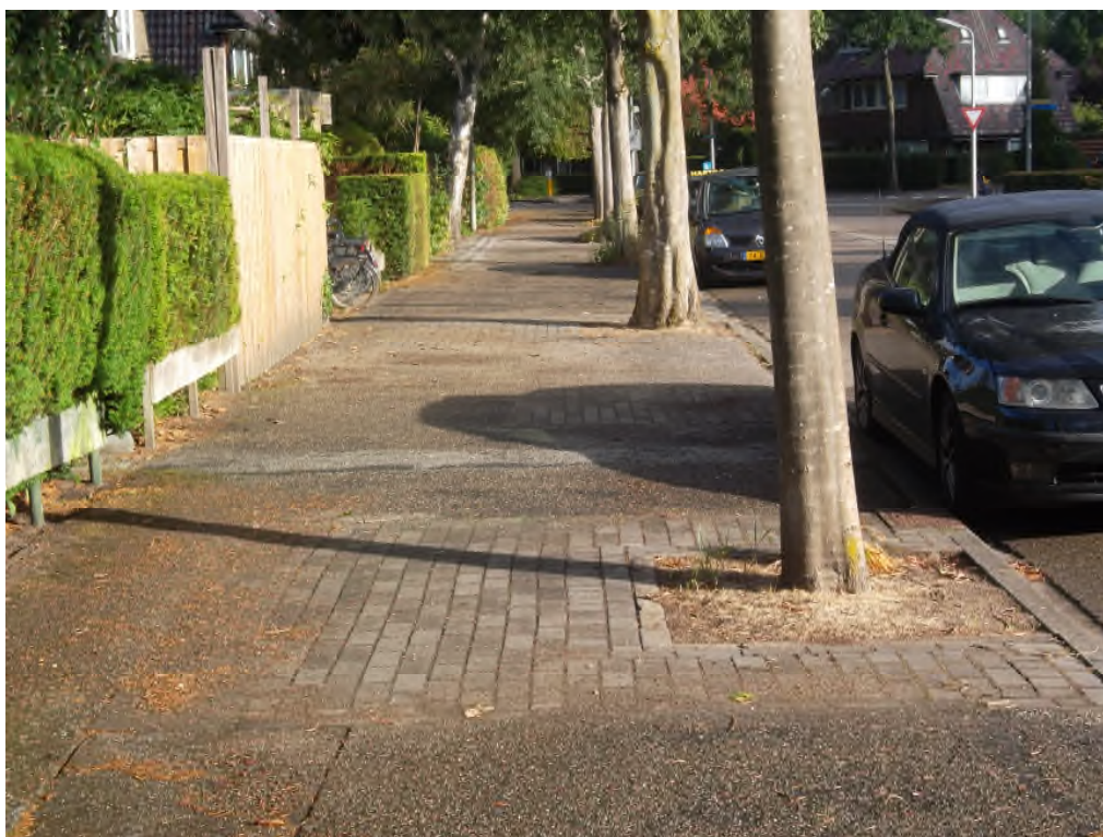
Foto 8. Detail standplaatsen van Celtisbomen in de Robert Kochstraat; de vakken met klinkers duiden zeer waarschijnlijk op een standplaatsverbetering ten tijde van de aanplant.
