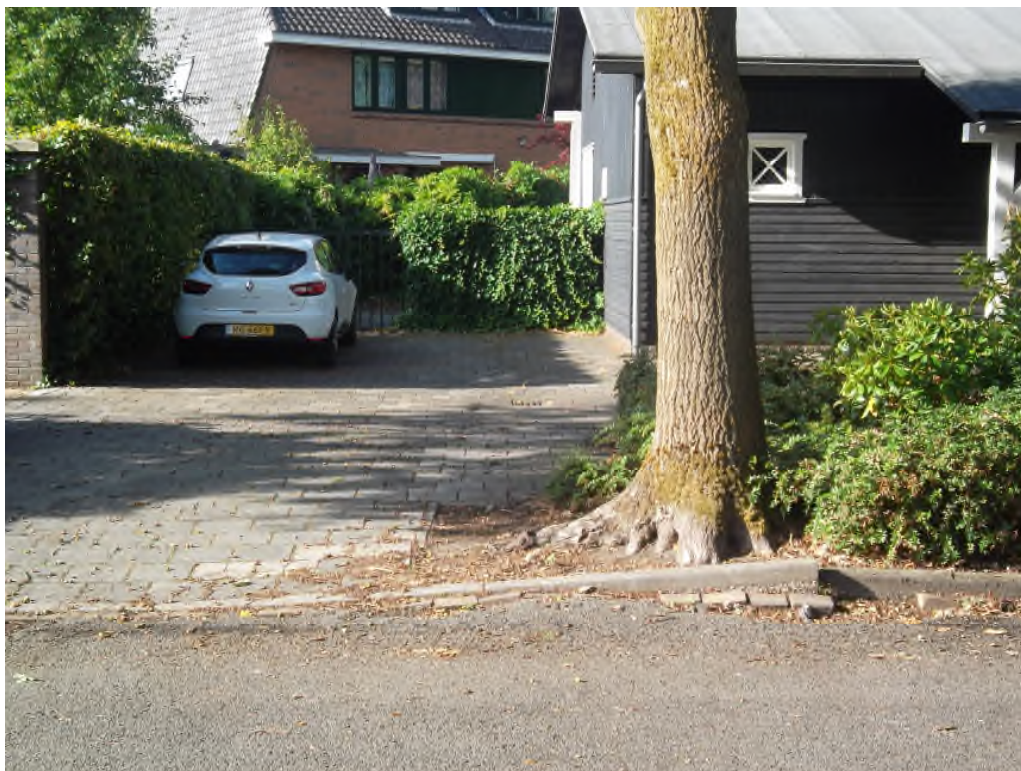
Foto 3. Kamerlingh Onnesstraat bij boom 13164: vrij zware opdruk opsluitband en standplaats pal langs oprit.
