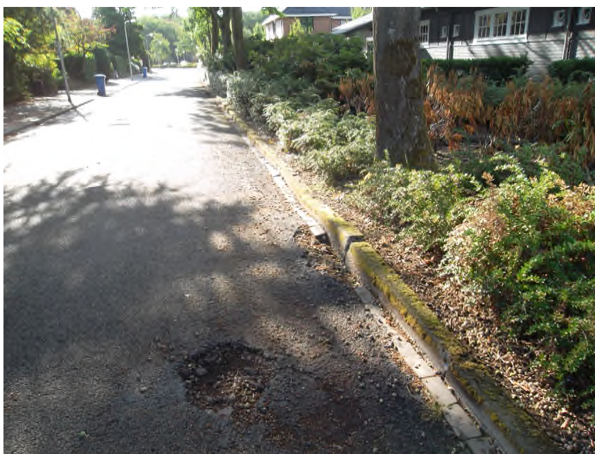
Foto 2. Kamerlingh Onnesstraat bij boom 13161: vrij zware opdruk opsluitband
