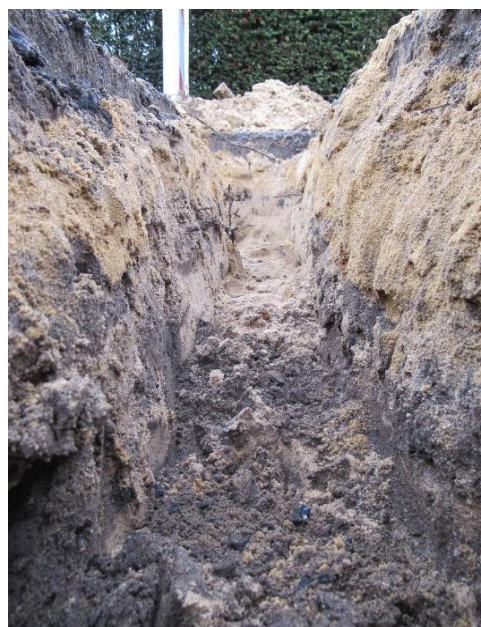
Foto: zijaanzicht proefsleuf
