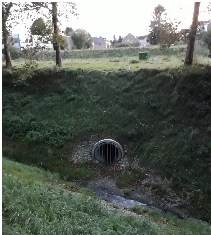
Foto 7: Een van de vele overstorten in de Caumerbeek en Palembergerbeek.
