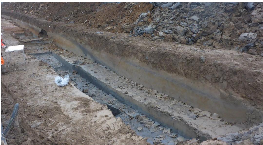
Figuur 5. Insnijding van de geul. Zichtbaar is de donkere bodem S5030 die steil wegduikt. Ter hoogte van de geul is lokaal een Romeinse vegetatiehorizont bewaard gebleven (rechtsboven).
