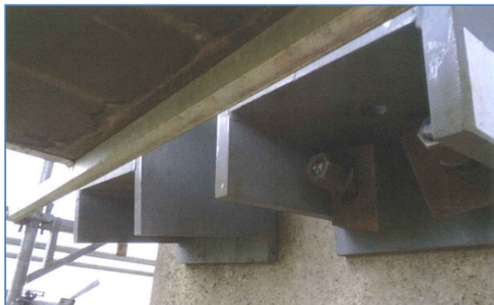
Fig. 10. Consoles verankerd aan de zijwand van de pijlers.
