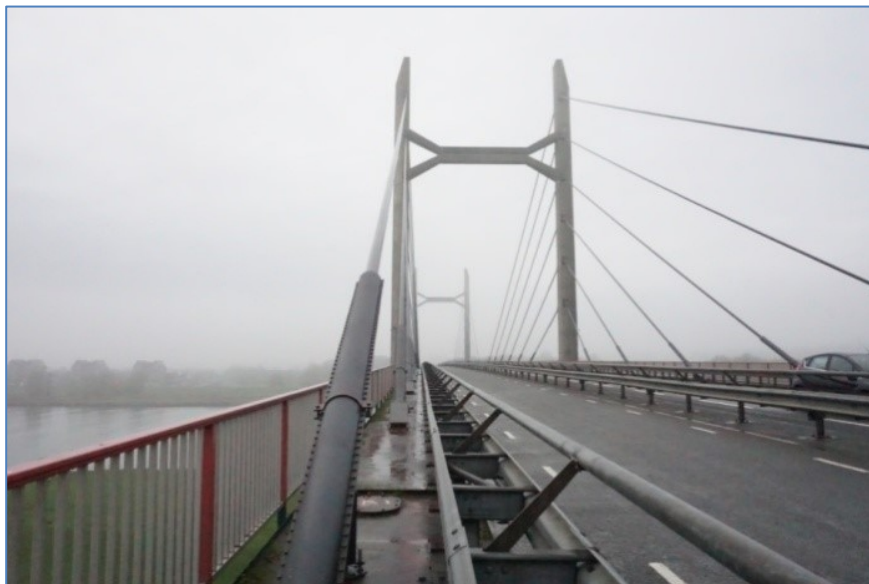
Fig. 3. Indeling van het wegdek van de hoofdbrug.
