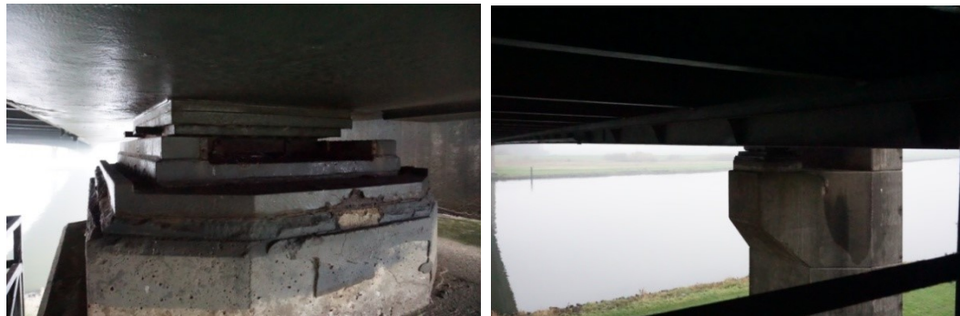
Fig. 13. Nokconstructie met beperkt aanwezige ruimte rondom bolsegmentopleggingen.
