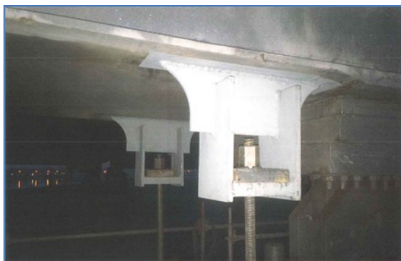
Fig. 11. Voerspananker aangebracht tussen console hoofdlijger en console zijwand pijler.
