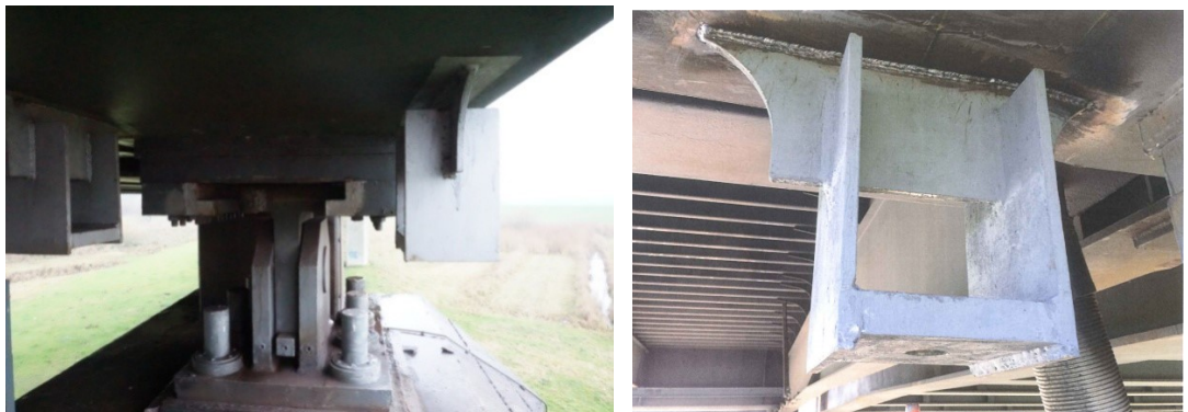
Fig. 9. Console gelast aan de onderzijde van een hoofdligger.
