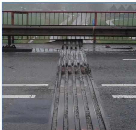
Fig. 14. Bestaande voegconstructie van het type Maurer D401.
