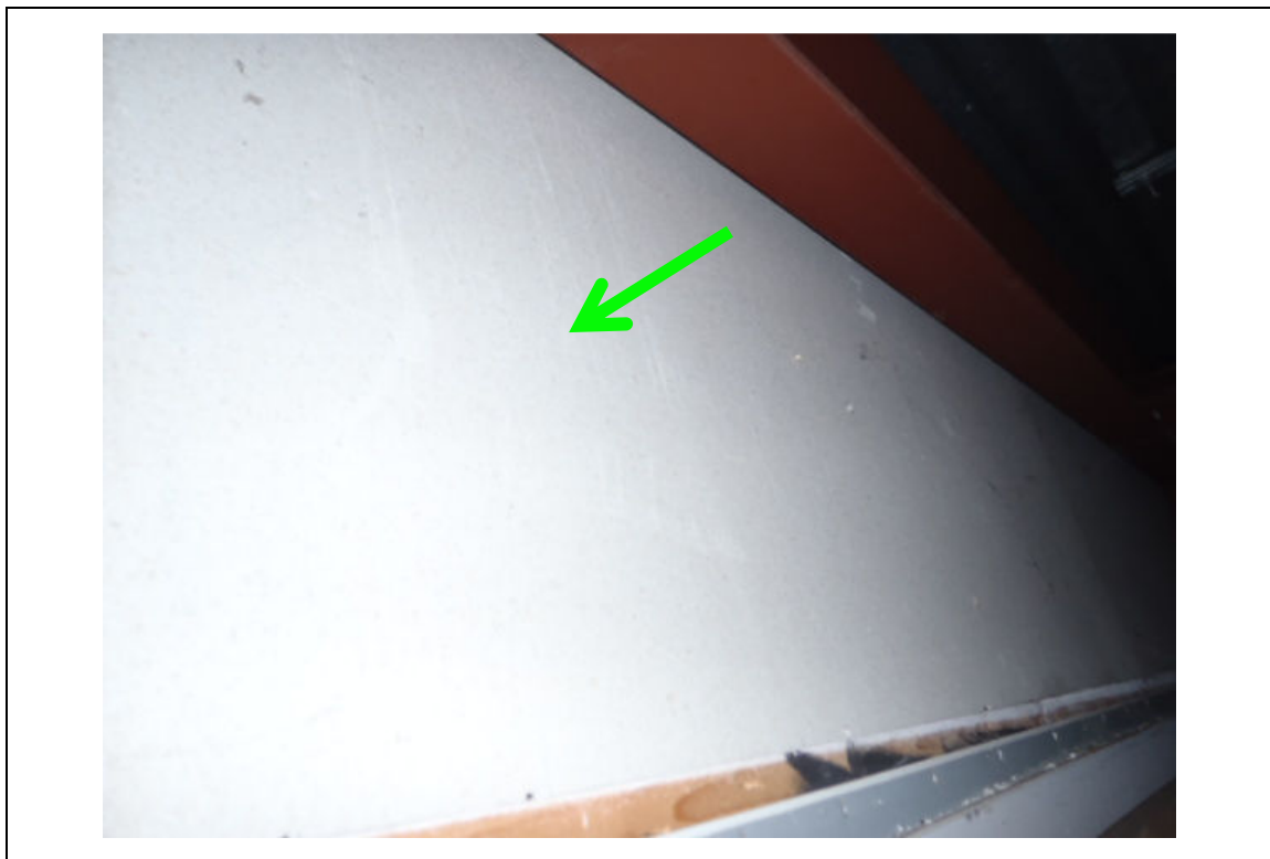
foto: 6, beplating (vezelplaat)
