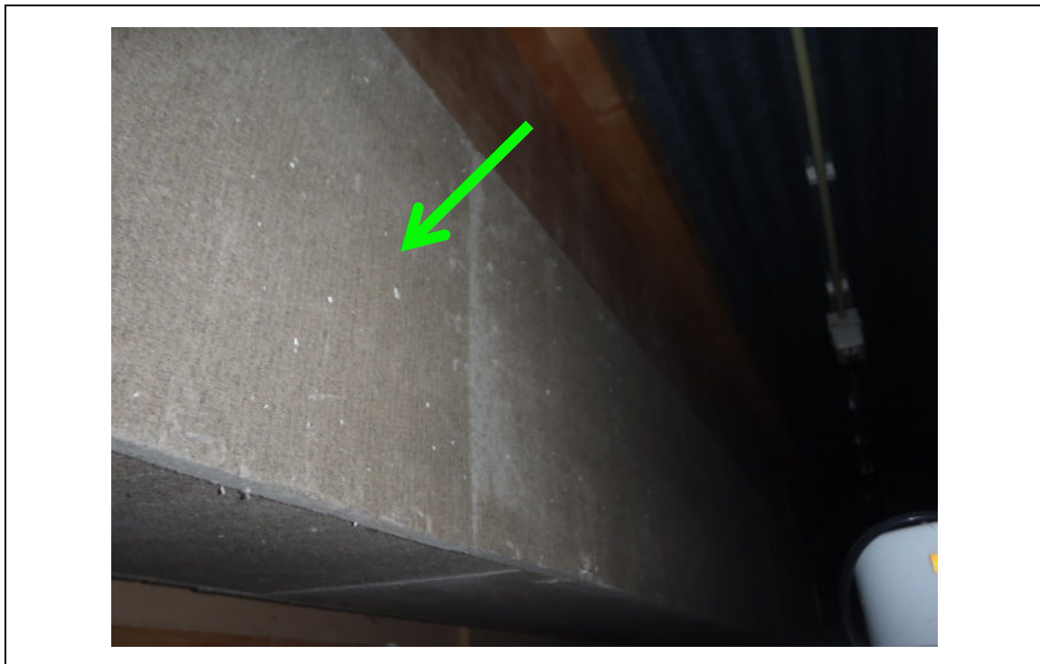
foto: 5, brandwerende beplating (vezelplaat)
