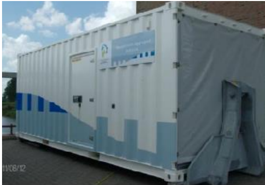
Fig. 18.3 : Noodstroom aggregaat NSA800-71 kan continue 690kVA vermogen leveren bij uitval elektrische energie.
