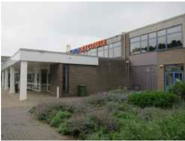
Foto bestaande entree en impressie nieuwe entrees (hoofdgebouw)
