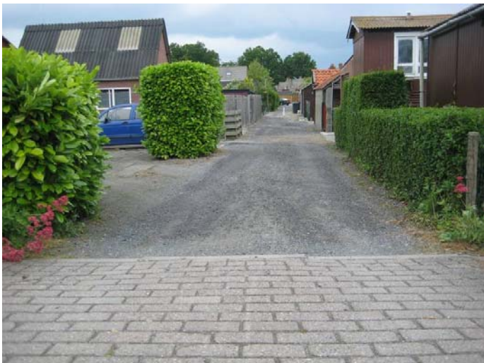
Figuur 6 Voorbeeld van een halfverhard achterpad
