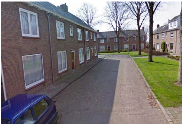
Figuur 7 Voorbeeld verouderde elementenverharding
