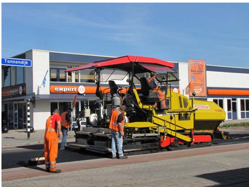
Figuur 1 Groot onderhoud asfaltverharding, vervangen van een deklaag
