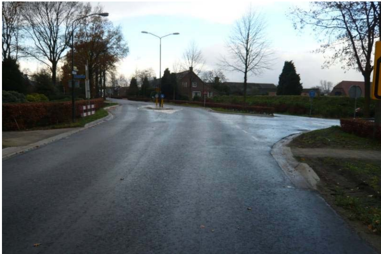
Figuur 3 Reconstructie van een asfaltweg
