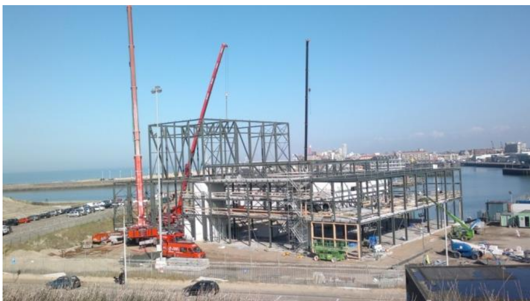
Figuur 2. De staalconstructie van het casco
