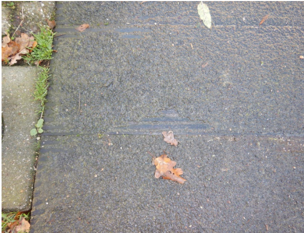
Figuur 4.12: De slijtlaag vertoont kale plekken door slijtage
