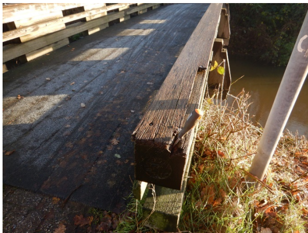
Figuur 4.8: De beide bovenste leuningregels vertonen houtrot
