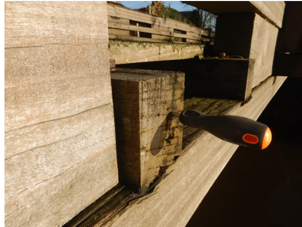
Figuur 4.6: De kopse kanten van de dwarsdragers vertonen aan de zuidzijde houtrot
