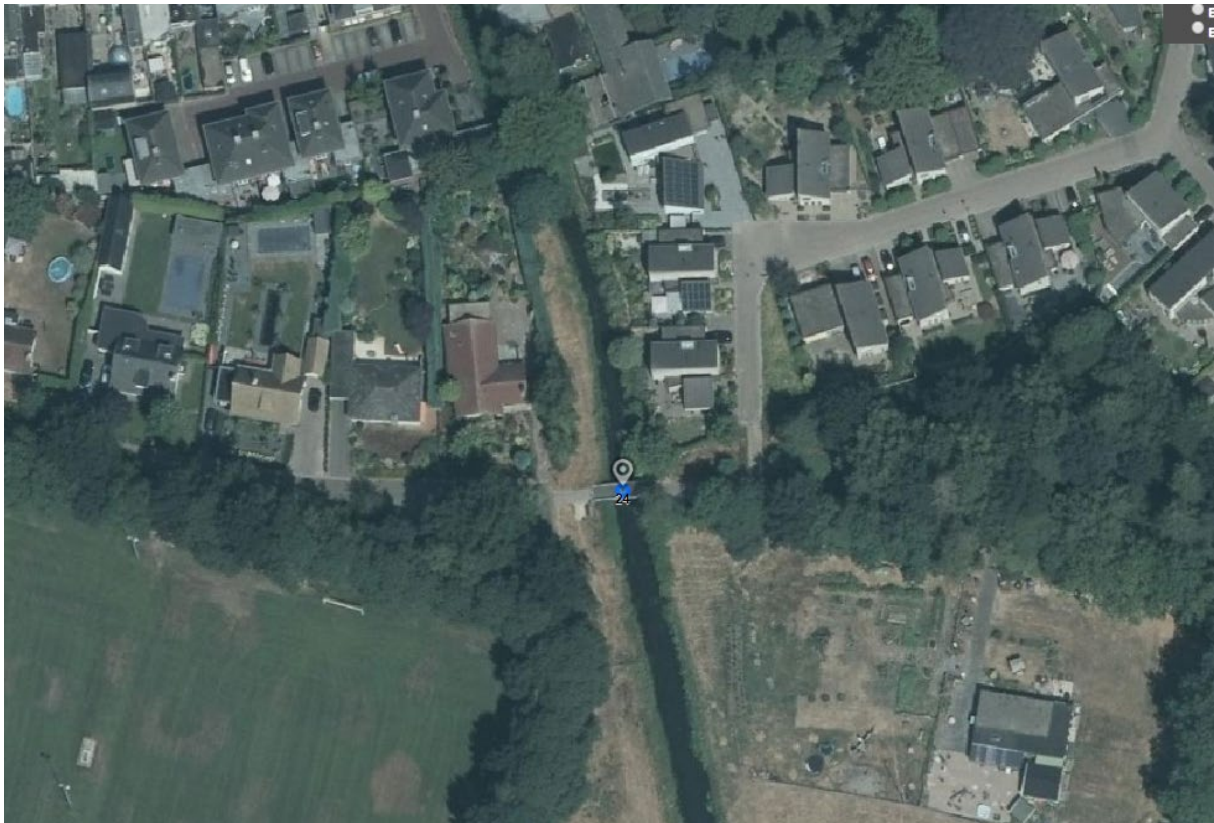
Figuur 1.1: Locatie brug 24 in de Sportlaan te Dongen
