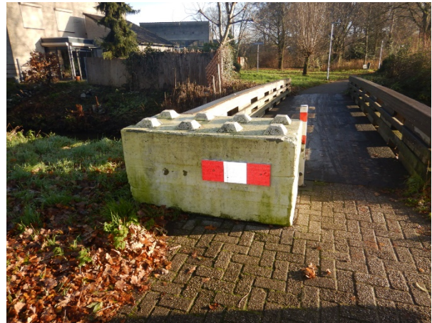
Figuur 4.15: De aansluitende elementenverharding vertoont aan de westzijde geen gebreken
