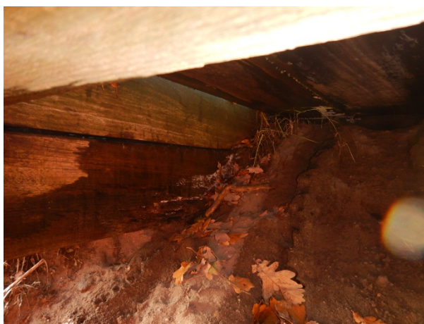
Figuur 4.10: Het oostelijk landhoofd is niet zichtbaar
