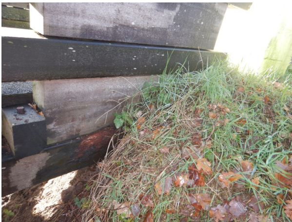
Figuur 4.3: Overzicht langsligger met aansluiting noordwestelijk talud
