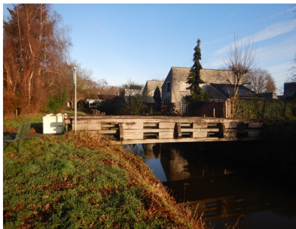
Figuur 2.2: Zuidelijk aanzicht
