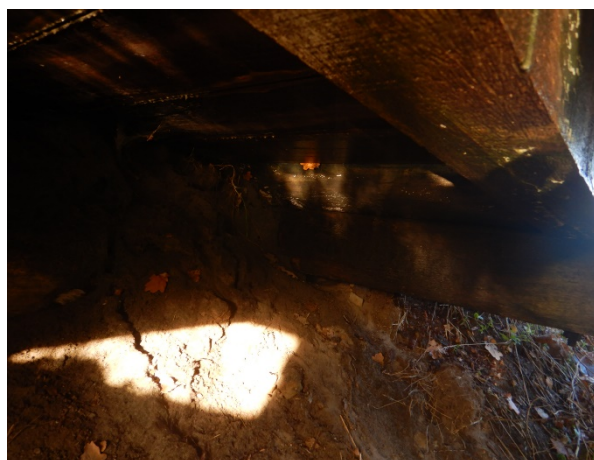
Figuur 4.11: Het westelijk landhoofd is niet zichtbaar
