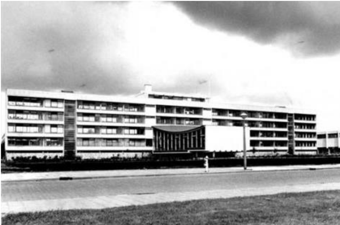
Figuur 2. Het te transformeren monumentale hoofdgebouw op kavel C/D
