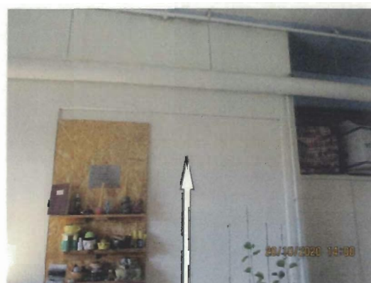
De zuurkast met asbesthoudend plafond is duurzaam afgeschermd.
