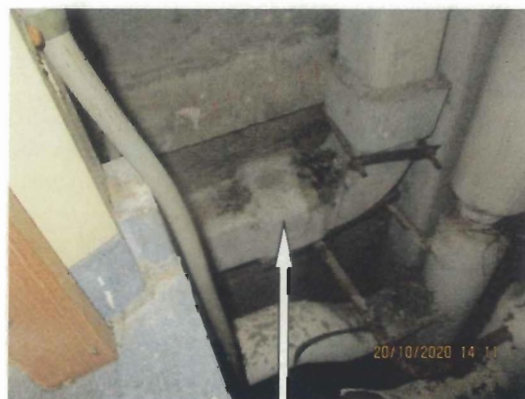
Ventilatiekanalen gebeugeld en plaatselijk ingemetseld.
