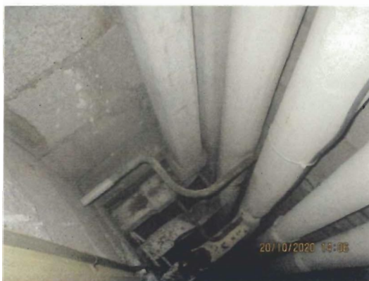
Ventilatiekanalen gebeugeld en plaatselijk ingemetseld.
