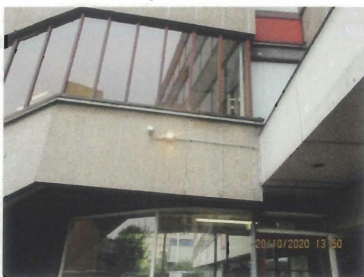
Asbesthoudende kit tussen betonnen gevelelementen.
