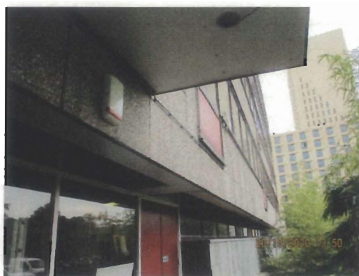
Asbesthoudende kit tussen betonnen gevelelementen.
