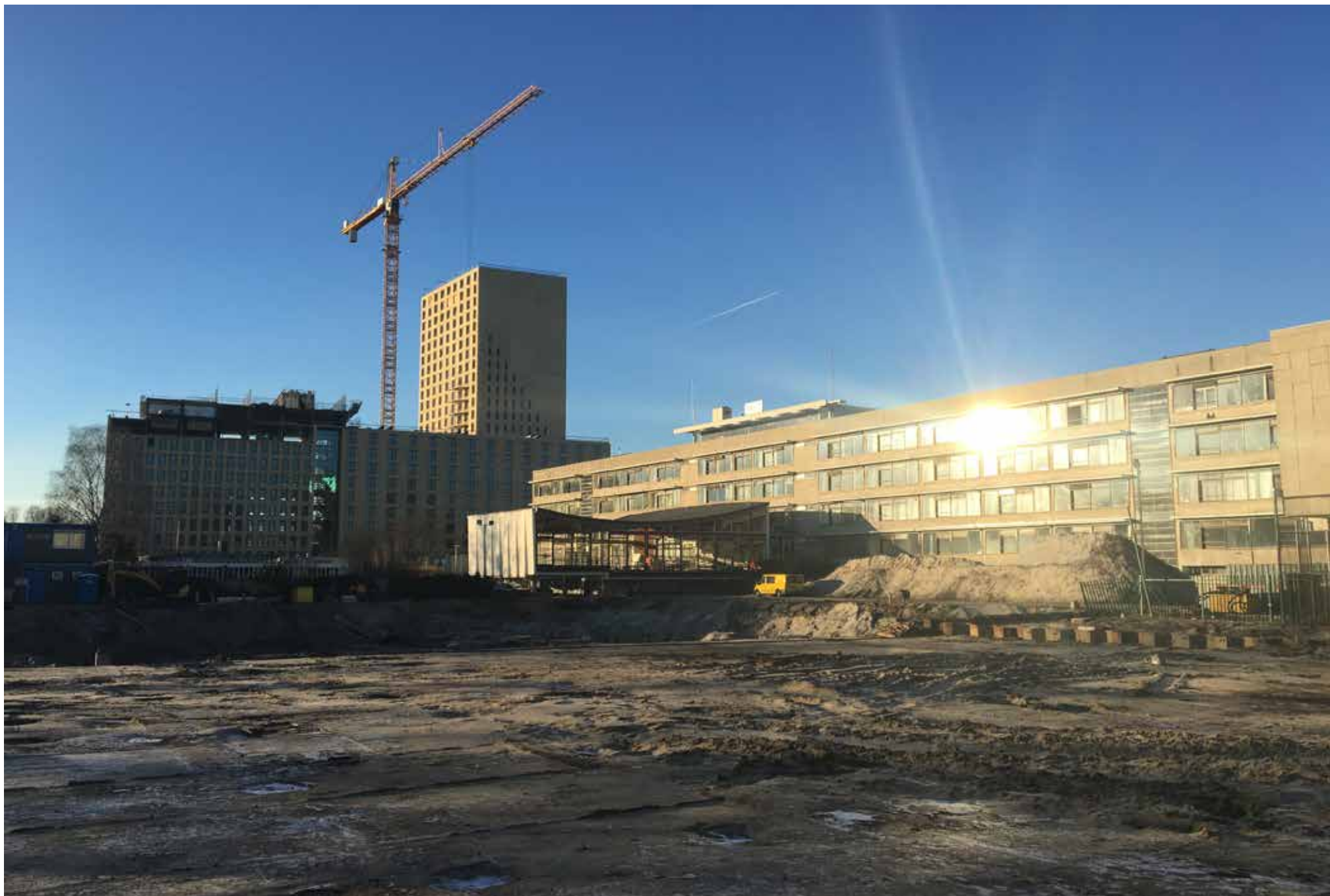
Hoofdgebouw met op de voorgrond kavel A en op de achtergrond Little Manhattan in aanbouw
