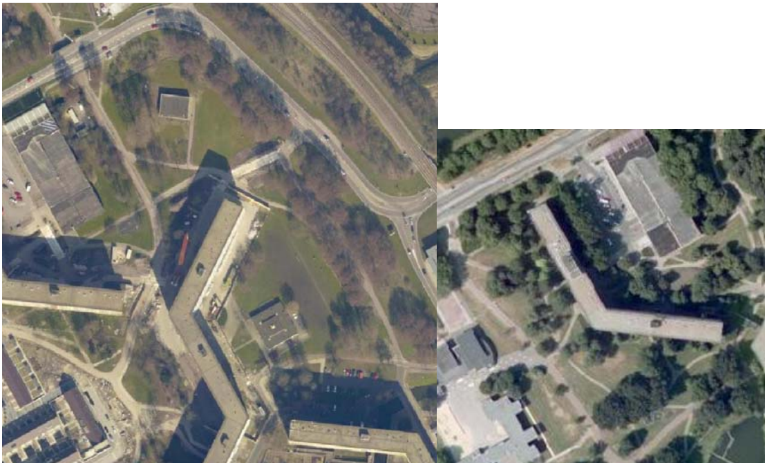
Figuur 3: Gesloopte hoogbouw Egeldonk op luchtfoto uit 2009 (links) en deels gesloopte hoogbouw Echtenstein op luchtfoto uit 2004 (rechts) [10]
