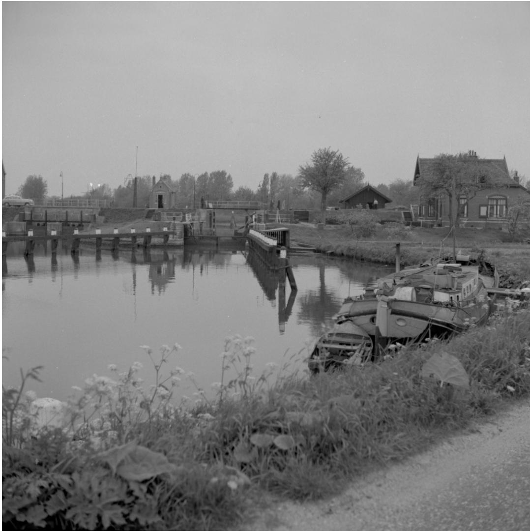
Afbeelding 1 Waaiersluis bij Gouda, gezien vanaf de bovenstroomse zijde, in 1946 ( http://beeldbank.rws.nl ).
