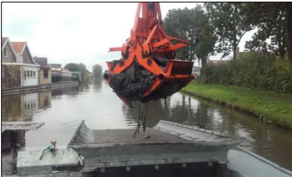
F2 het ontgraven van een proefsleuf
