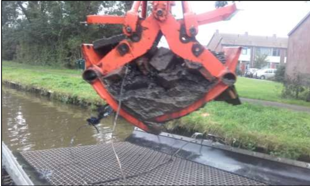
F1 het ontgraven van een proefsleuf
