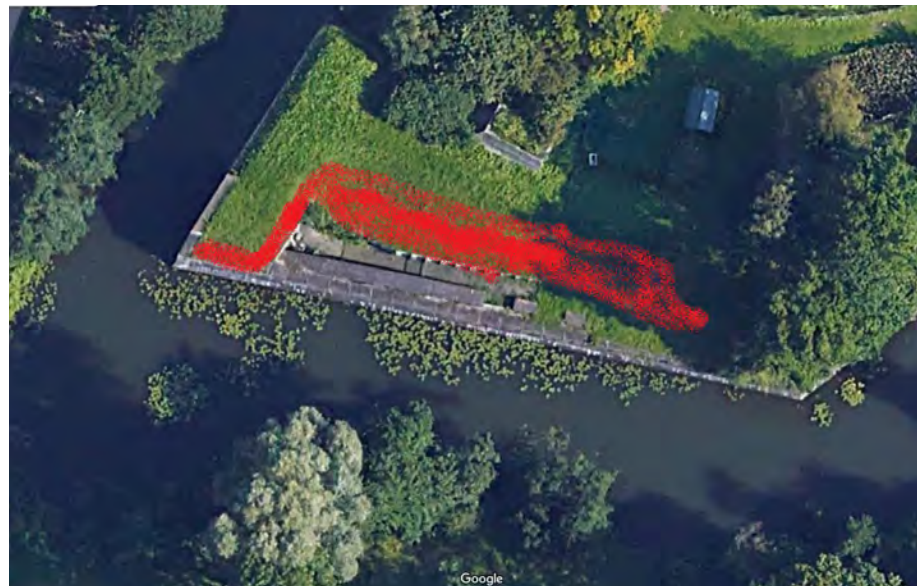
Figuur 46 Detail van de zuidelijke kademuur van fort Lunet I, met in rood het daadwerkelijke talud weergegeven waar zich de nestaggregatie bevindt.
