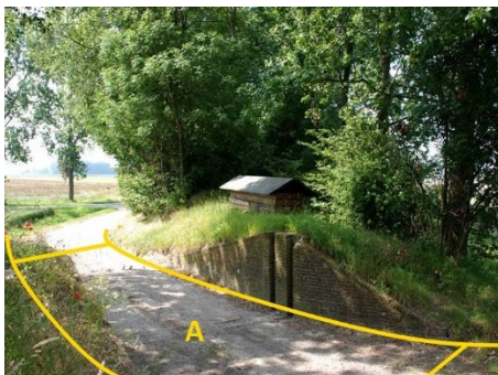
Coupure Wijk bij Duurstede (schuifdeur en 2 sponningen)
