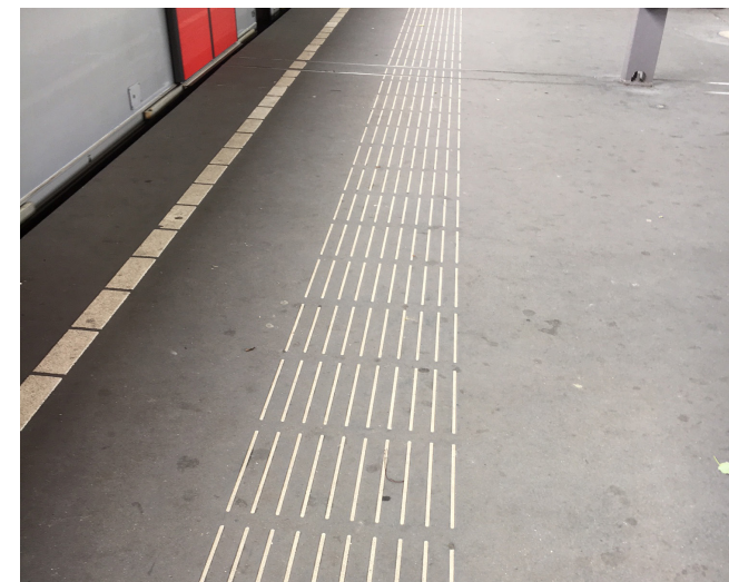
Bij Metro en Tram worden geleidelijnen Type 2 gebruikt; ribbels op bestaande vloer met 10 ribbels.
