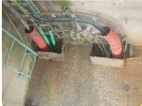
Figuur 76: Zinker oplegpijler
