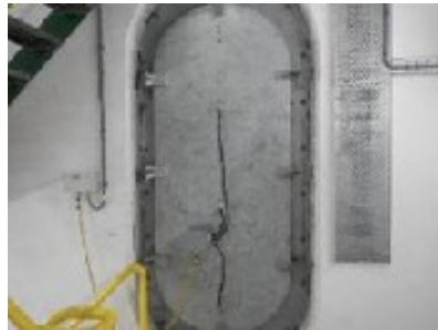
Figuur 49: SVS basculekelder binnen
