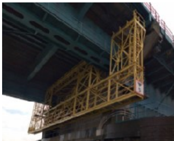
Figuur 78: Inspectiewagen beweegbare brug
