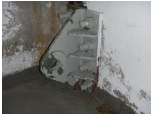
Figuur 33: Vastzetinrichting oostzijde
