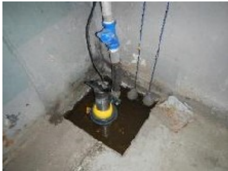
Figuur 71: Lenspomp kelder
