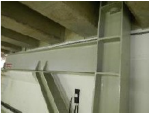
Figuur 70: Hijsvoorziening achter aandrijving
