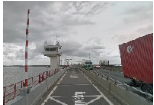
Figuur 53: Gecombineerde afsluitboom
