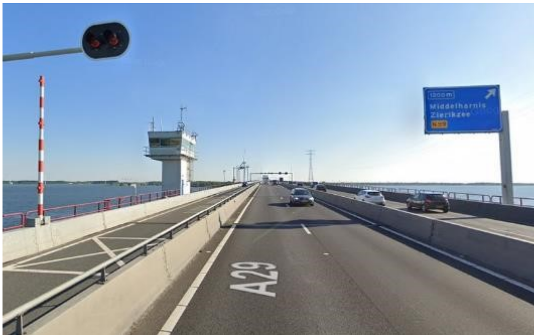
Figuur 9 Parallelweg en Rijksweg
