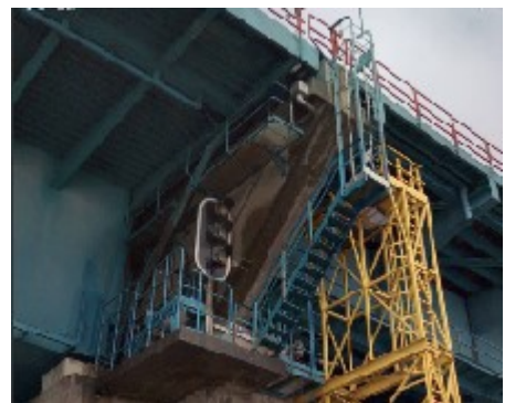
Figuur 67: Bordessen en trappen, toegang oplegpijler
