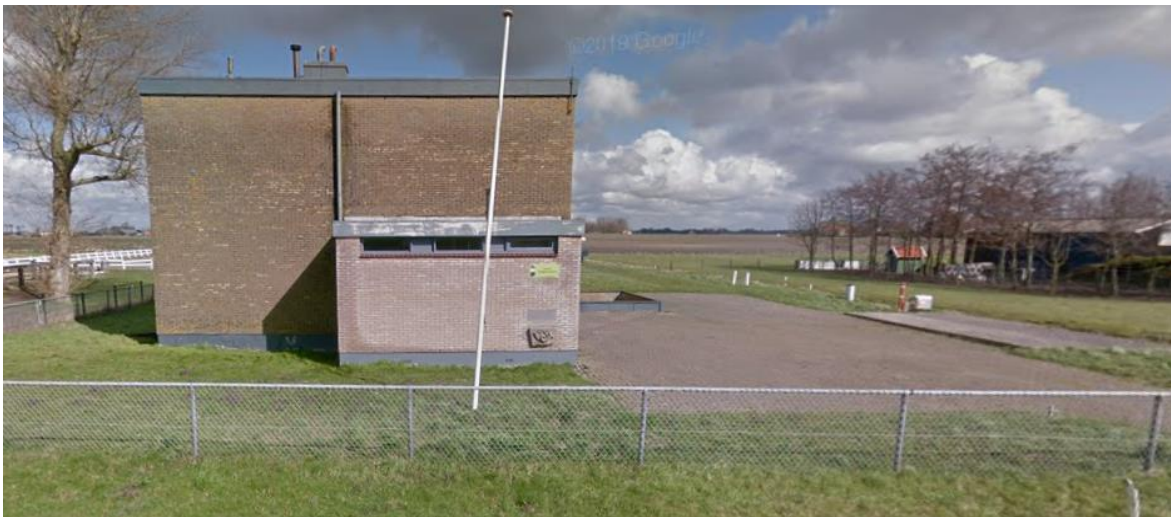
Figuur 1-1 - Gemaal Oudenhoorn, aan de Zeedijk 3.
