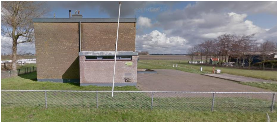
Figuur 3-1 - Gemaal Oudendoorn, huidige situatie
