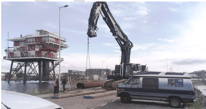
Figuur 6: damwandkraan tbv aanbrengen casing
