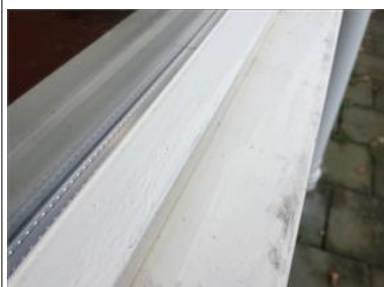
Onvoldoende dekking
