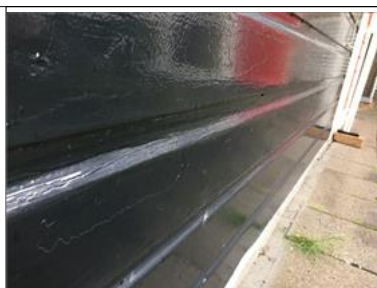
Omkanten onvoldoende behandeld
