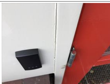
Openstaande verbindingen
