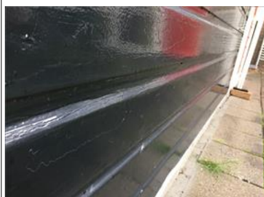
Scheuren (hout, wind-, droog-, krimp-, slijtscheuren)
