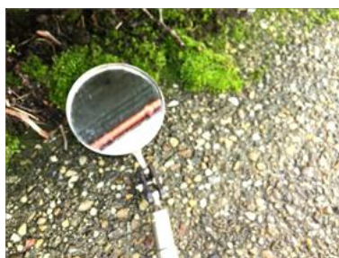
Omkanten onvoldoende behandeld
