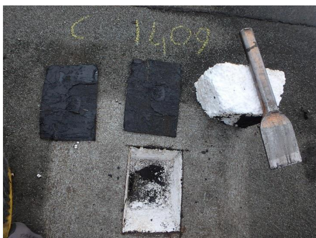
Foto 41 Insijding meetwaarde 1409 (betondak)
