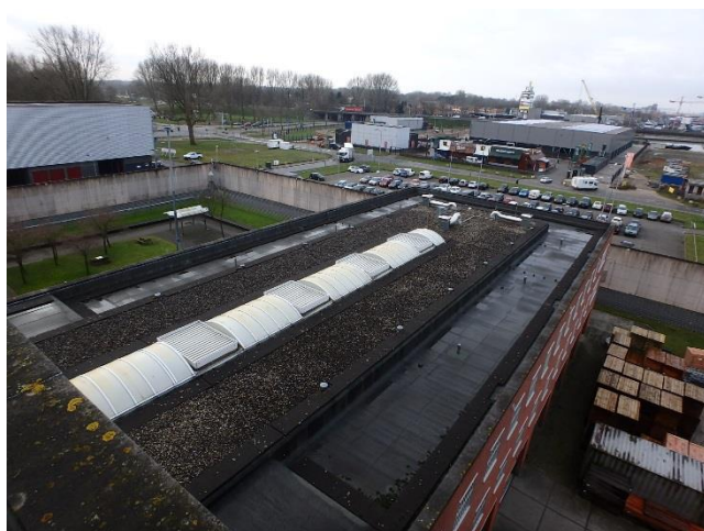
Foto 93 Overzicht daken bouwdeel L
