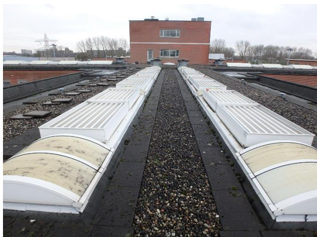
Foto 57 Overzicht dakvlak E2
