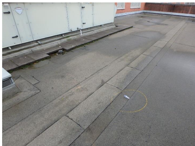
Foto 10 Overzicht afwerking 'dilatatie'
