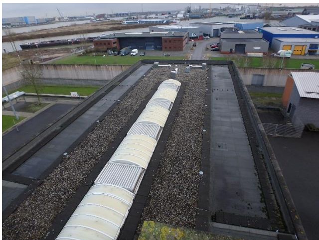
Foto 61 Overzicht daken bouwdeel F
