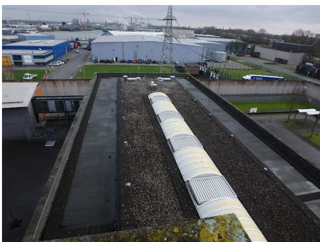
Foto 77 Overzicht dakvlakken bouwdeel J
