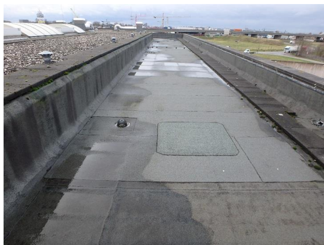
Foto 44 Overzicht dakvlak D1, deels overlaagd
