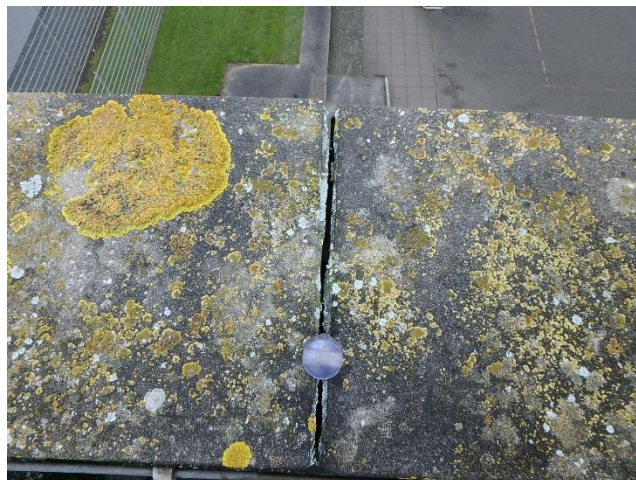
Foto 80 Onthechting kit betonnen randelementen
