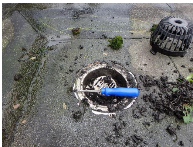
Foto 54 Onthechting plakstuk van hemelwaterafvoer
