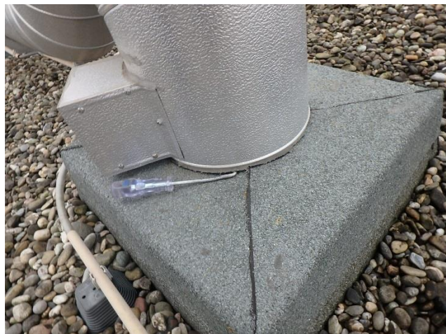
Foto 100 Onthechting kitafwerking installatie
