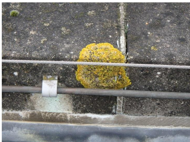
Foto 3 Onthechting kitvoegen betonnen randelementen
