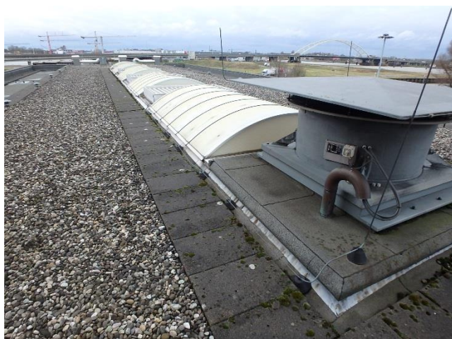
Foto 47 Overzicht dakvlak D2
