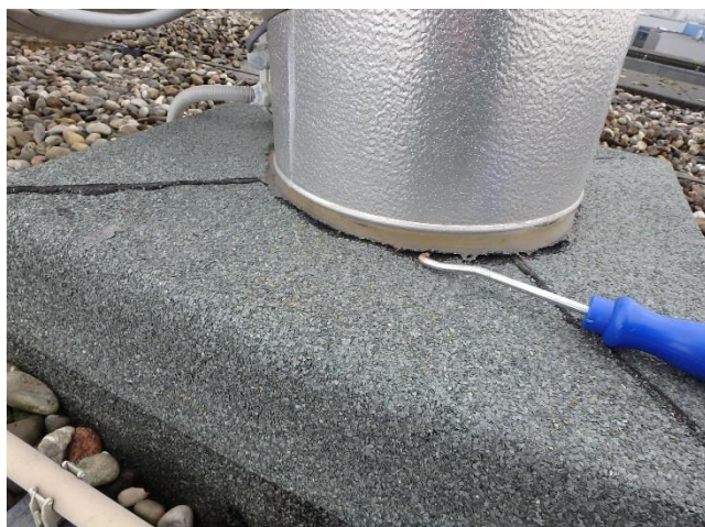
Foto 69 Onthechting kitafwerking installatie
