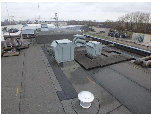
Foto 33 Overgang dakvlak C met C/H
