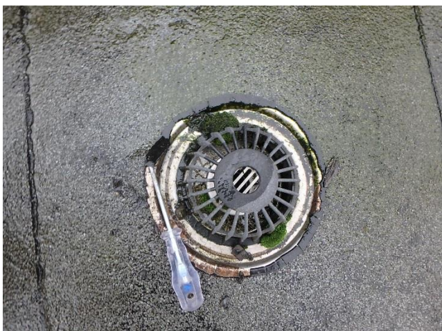
Foto 81 Onthechting plakstuk hemelwaterafvoer
