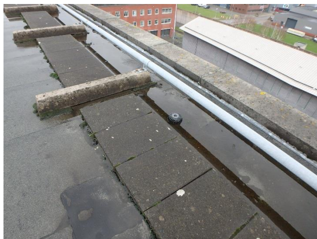
Foto 34 Overmatige pasvorming (hemelwaterafvoer verstoppt)
