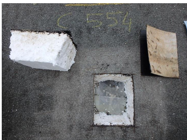
Foto 39 Insijding meetwaarde 554 (staaldak)
