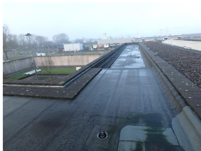
Foto 94 Overzicht dakvlak L1
