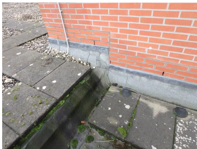
Foto 74 De opstandafwerking (spouwlood) is vernieuwd
