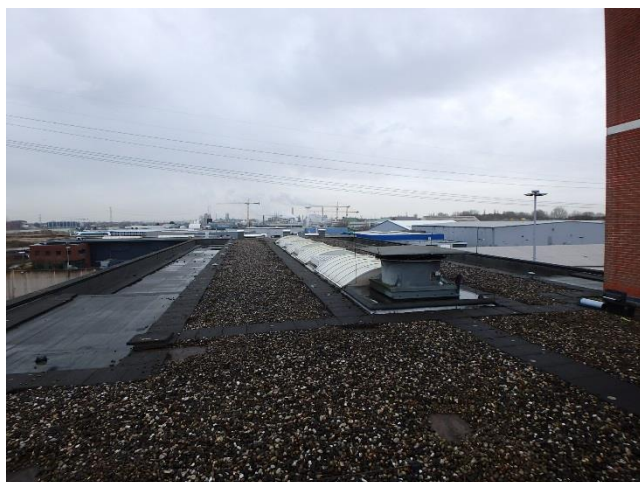
Foto 67 Overzicht dakvlak F2
