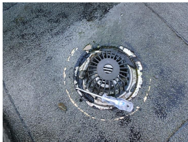
Foto 96 Onthechting plakstuk hemelwaterafvoer
