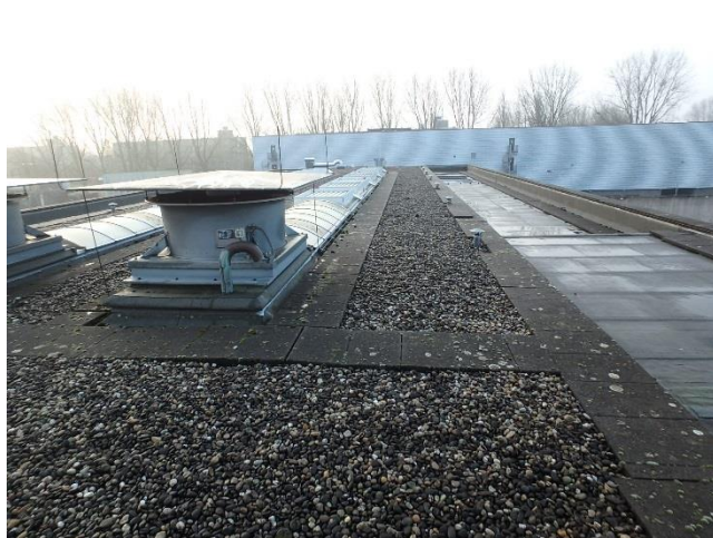
Foto 89 Overzicht dakvlak K2
