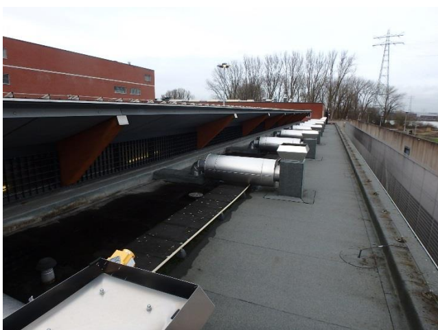
Foto 101 Overzicht dakvlak bouwdeel R
