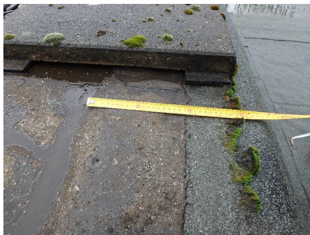
Foto 68 Overzicht aansluiting met dakvlak F1
