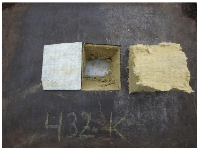
Foto 91 Insnijding meetwaarde 432 (staaldak)
