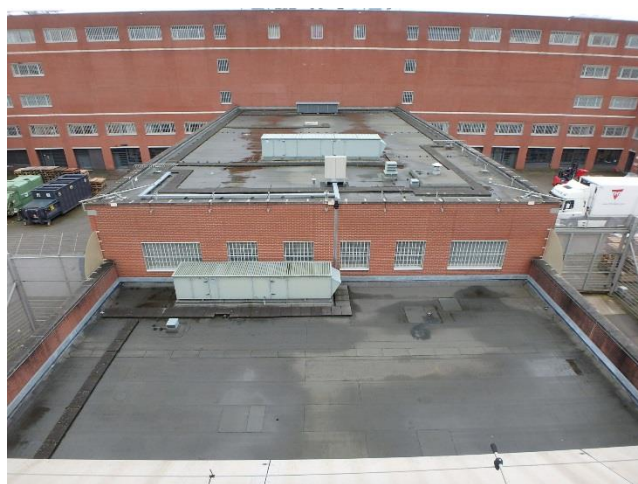
Foto 8 Overzicht dakvlakken bouwdeel B
