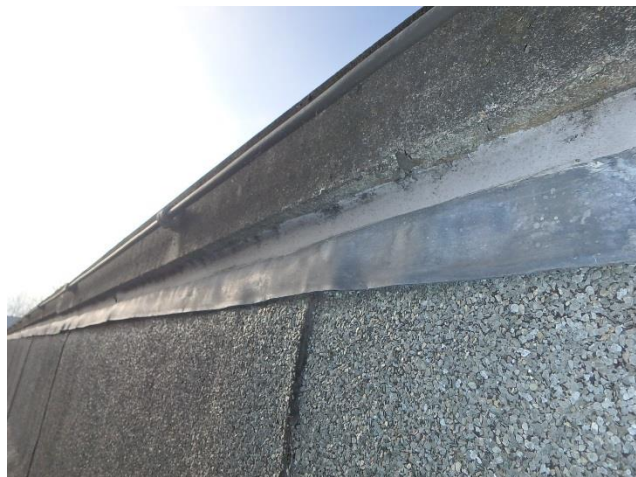
Foto 98 Hernieuwde kitafwerking onderzijde betonband
