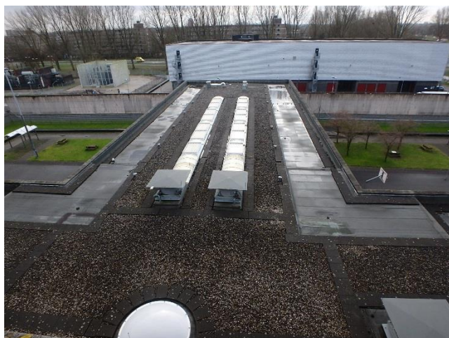
Foto 85 Overzicht dakvlakken bouwdeel K
