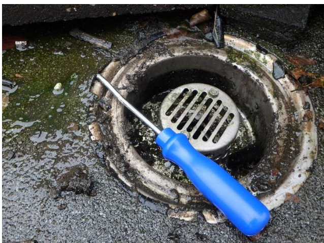
Foto 15 Onthechting plakstuk hemelwaterafvoer
