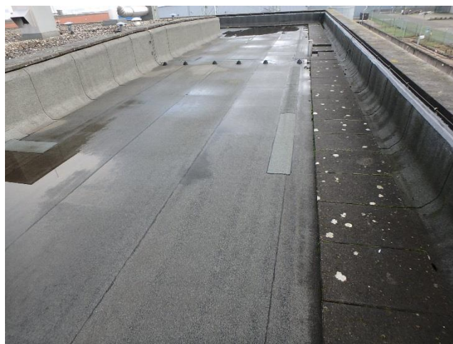
Foto 86 Overzicht dakvlak K1
