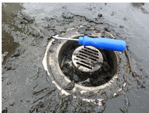
Foto 24 Onthechting plakstuk hemelwaterafvoer
