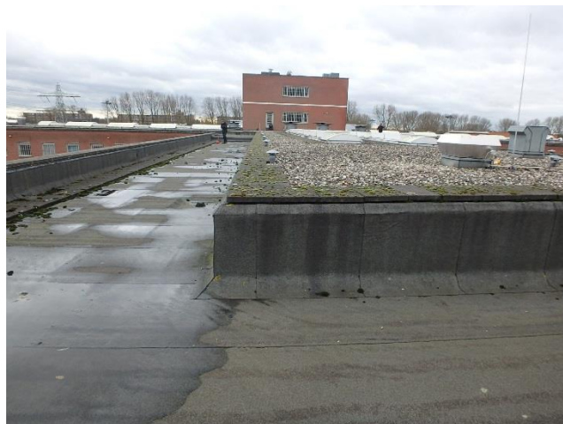
Foto 50 Overzicht dakvlak E1
