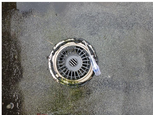
Foto 88 Onthechting plakstuk van hemelwaterafvoer
