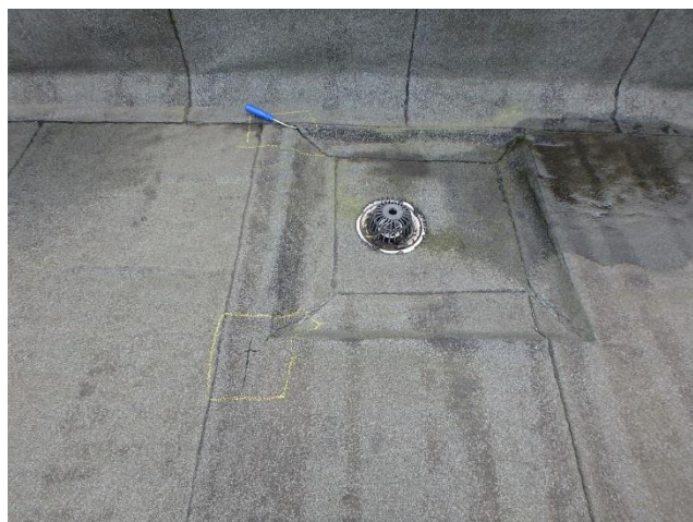
Foto 52 Onthechting overlappen bij hemelwaterafvoer
