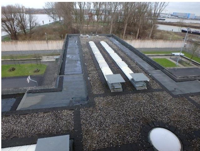
Foto 49 Overzicht dakvlakken bouwdeel E
