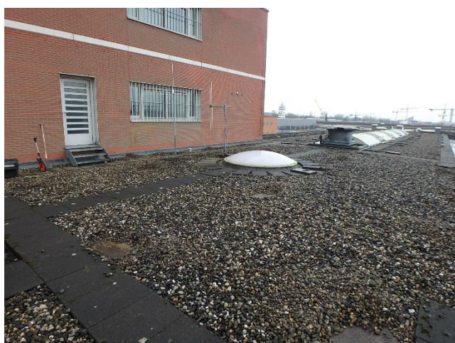
Foto 71 Overzicht dakvlak bouwdeel G
