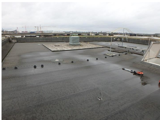
Foto 1 Overzicht dakvlak bouwdeel A
