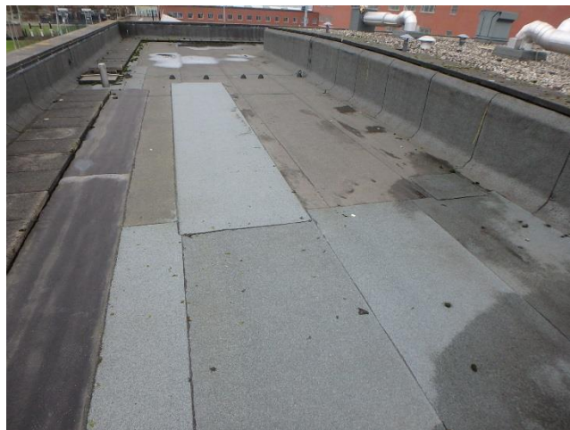
Foto 62 Overzicht dakvlak F1, diverse delen overlaagd
