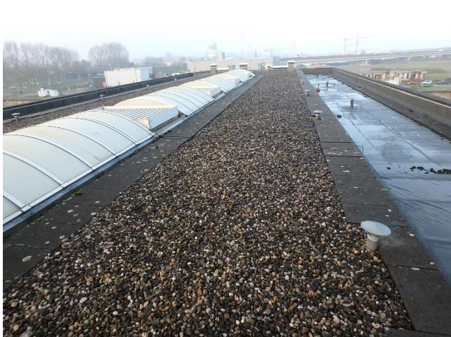
Foto 99 Overzicht dakvlak L2
