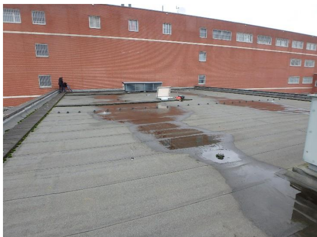
Foto 21 Overzicht dakvlak B2
