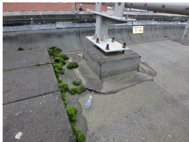
Foto 28 Onthechting opstandstrook poer stroombeveiliging
