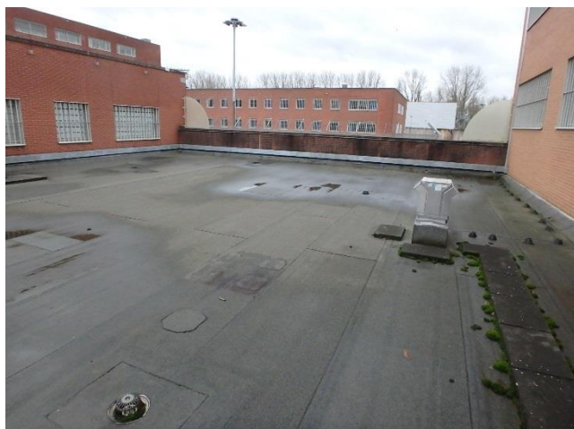
Foto 9 Overzicht dakvlak B1
