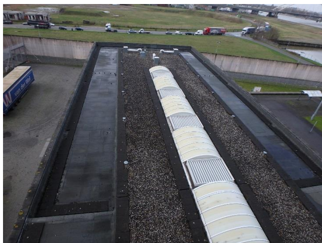
Foto 43 Overzicht dakvlakken bouwdeel D
